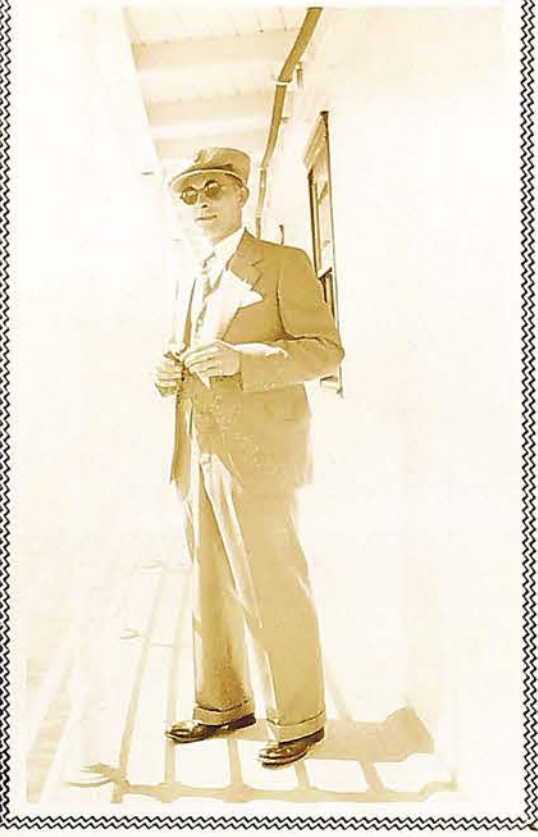
SUR LE PONT DU QUEBEC. 27/6/34
