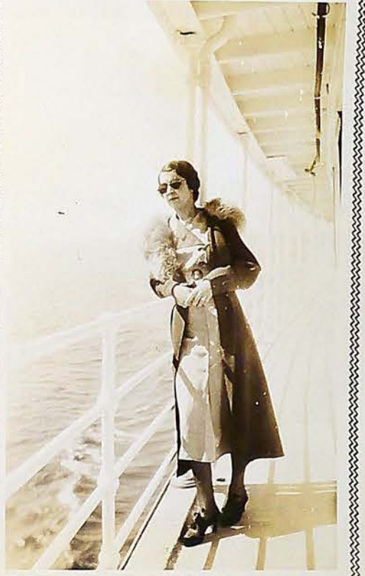
SUR LE PONT DU QUEBEC. 27/6/34
