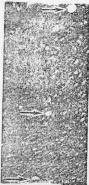
Voici les disques dans le pavé. L'usure est mesurée visuellement par l'examen des couleurs.
