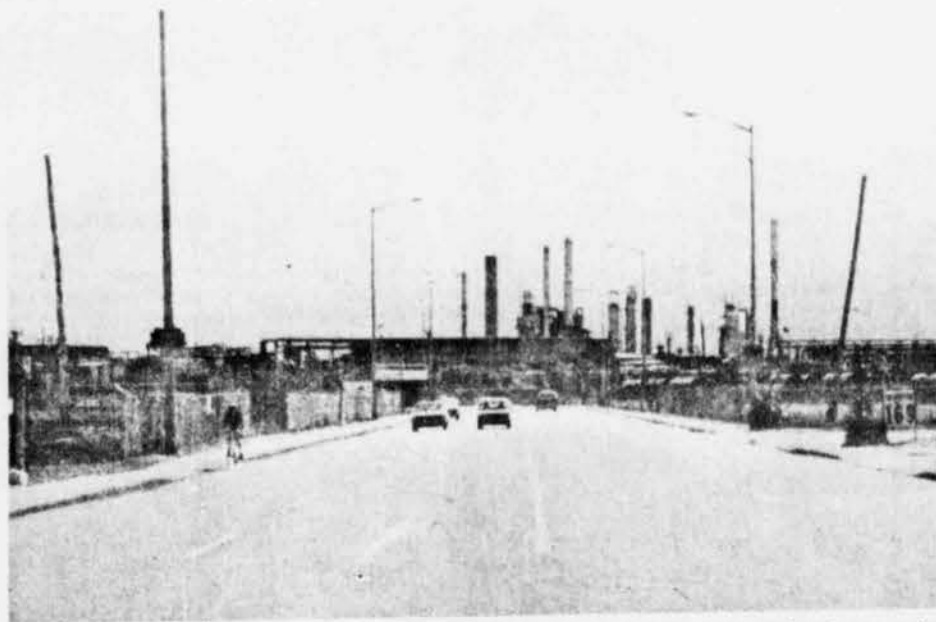
Les vastes territoires des pétrolières dans Montréal-Est constituent un intérêt plus ou moins grand. La pollution avancée du sous-sol par les produits pétroliers les rendraient impropres à une nouvelle vocation industrielle pour plusieurs années.
