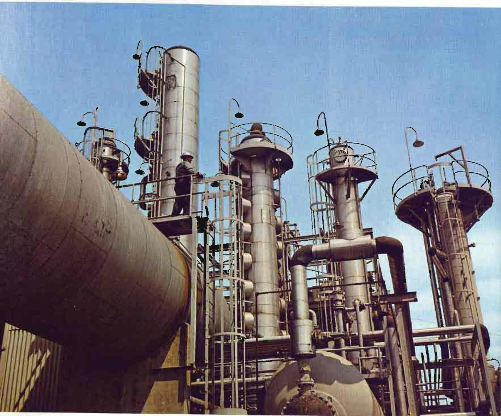
*Ces hautes tours dominent une partie des installations où sont transformés les essences et les carburants • Towers dwarf operator at Polymerization unit where light gasoline molecules are converted into high-quality, high-octane polymer gasoline • Torres de refinamiento de carburantes • Torri di raffinamento del carburante • Diese Türme überragen die Polymerisationseinrichtungen wo Leichtbenzin-Moleküle in oktandreiches Benzin umgewandelt werden.*
