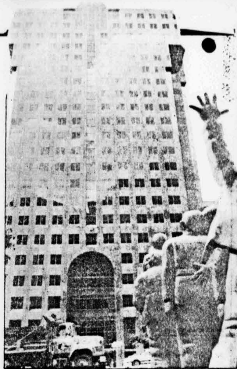
L'immeuble de l'Industrielle-Vie, un modèle exemplaire de ce que l'on appelle le postmodernisme, où l'on n'a pas lésiné sur la qualité des matériaux employés.
