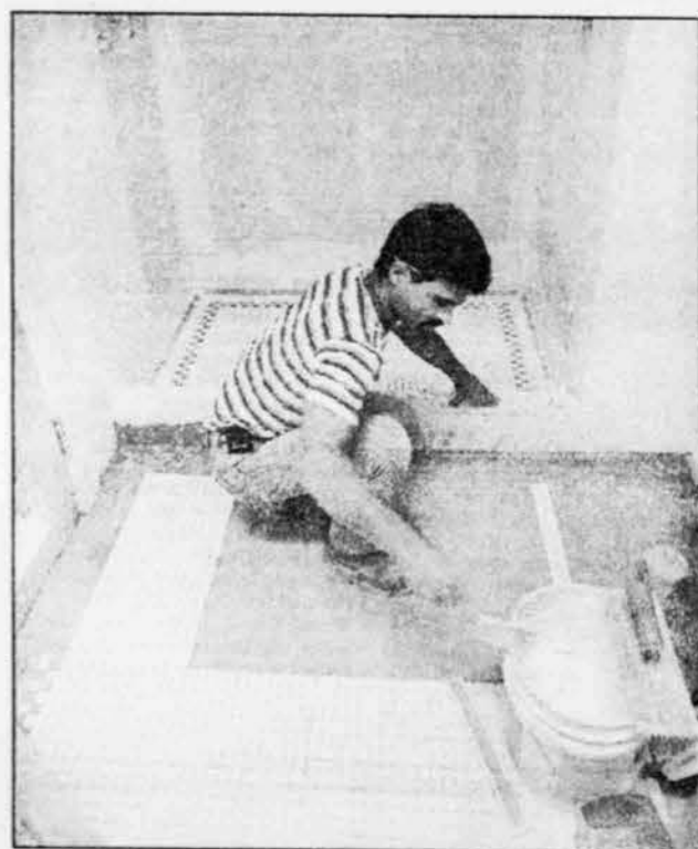
Dans la salle de toilette avec douche du maire, au quatrième étage, pas de marbre; que des tuiles de céramique blanche avec taches de couleur en bordure.
