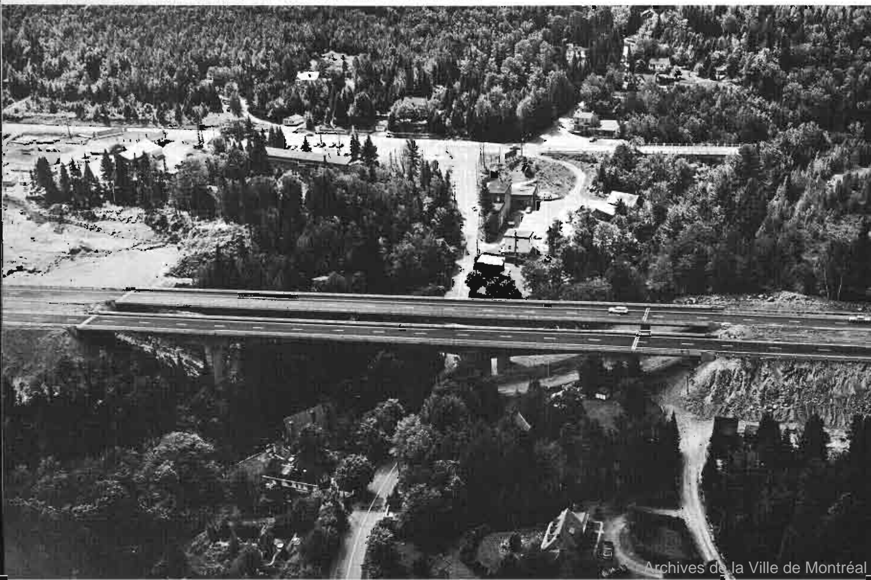
Ponts jumelés de l'Autoroute des Laurentides, près de Ste-Adèle • Scene at Val Morin shows how Laurentien Autoroute cuts through mountain resort area, providing ready access for motorists • Puentes de la Autoruta de las Lauréntidas, cerca de St-Adelu • Il doppio ponte dell'Autostrada delle colline Laurenziane, nei pressi di Ste-Adèle • Ein Teil der Autoroute zwischen Sainte-Adèle und Val Morin in den Laurentinerbergen.
