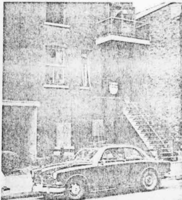
Depuis le feu de mai dernier au 748 Agnès, rien de bien concret n'a été accompli afin de préserver la vie des gens. Les fenêtres brisées risquent de tomber sur la tête des passants, des morceaux de bois chambrant à tout moment, etc. Ce qui est incroyable: le propriétaire de la maison ne semble pas tellement conscient du danger qui guette les gens du voisinage.
