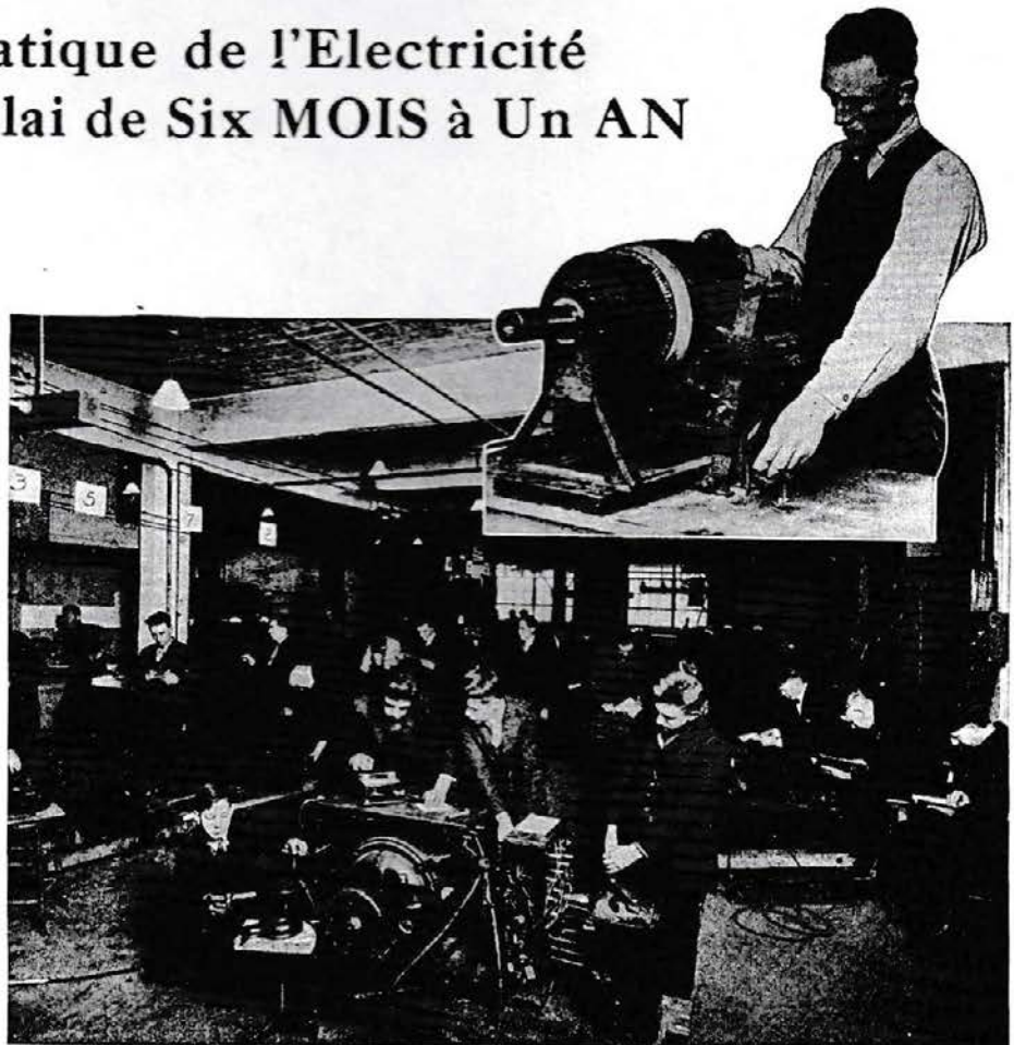
Les étudiants apprenant à faire les travaux d'électricité tels qu'ils sont effectués sur les chantiers de construction.
