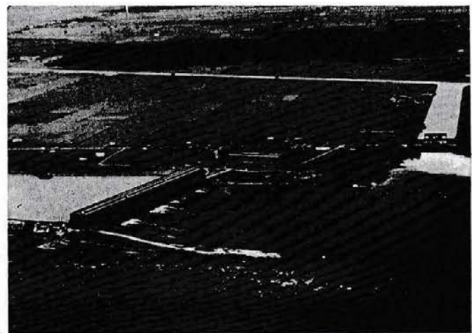
Vue aérienne de la Station d'Énergie Électrique (205,400 C.V.) des Rapides des Cèdres, de l'usine de transformation et de la Station d'Énergie Électrique (16,650 C.V.) de Soulanges.
