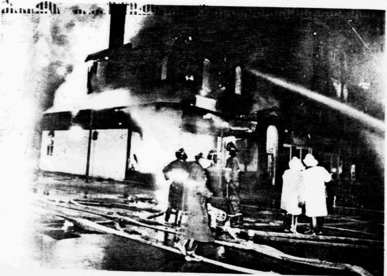
Près d'un million de dollars de dommages ont été causés à un immeuble en rénovation, à l'intersection Milton et Avenue du Parc.
