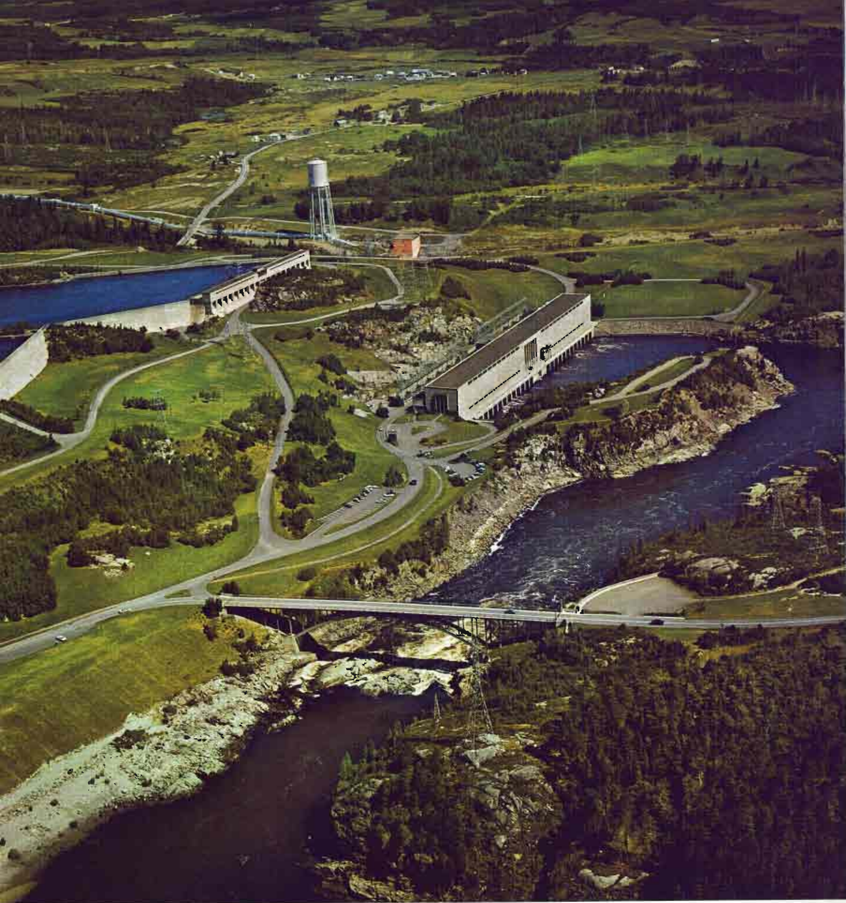
La Centrale de Shipshaw, d'une capacité installée de 895,000 kw, alimente l'usine d'Arvida • Shipshaw powerhouse with an installed capacity of 895,000 kw supplies electricity to nearby Arvida aluminum smelter • La central de Shipshaw, de una capacidad instalada de 895,000 kw, alimenta la fábrica de Aluminio de Arvida • La centrale idroelettrica di Shipshaw, potenziale 895 mila kw., fornisce l'elettricità all'industria di alluminio della vicina Arvida • Das Shipshaw Kraftwerk mit einer Kapazität von 895,000 Kilowatt versorgt das nahegelegene Aluminiumschmelzwerk in Arvida mit elektrischem Strom.
