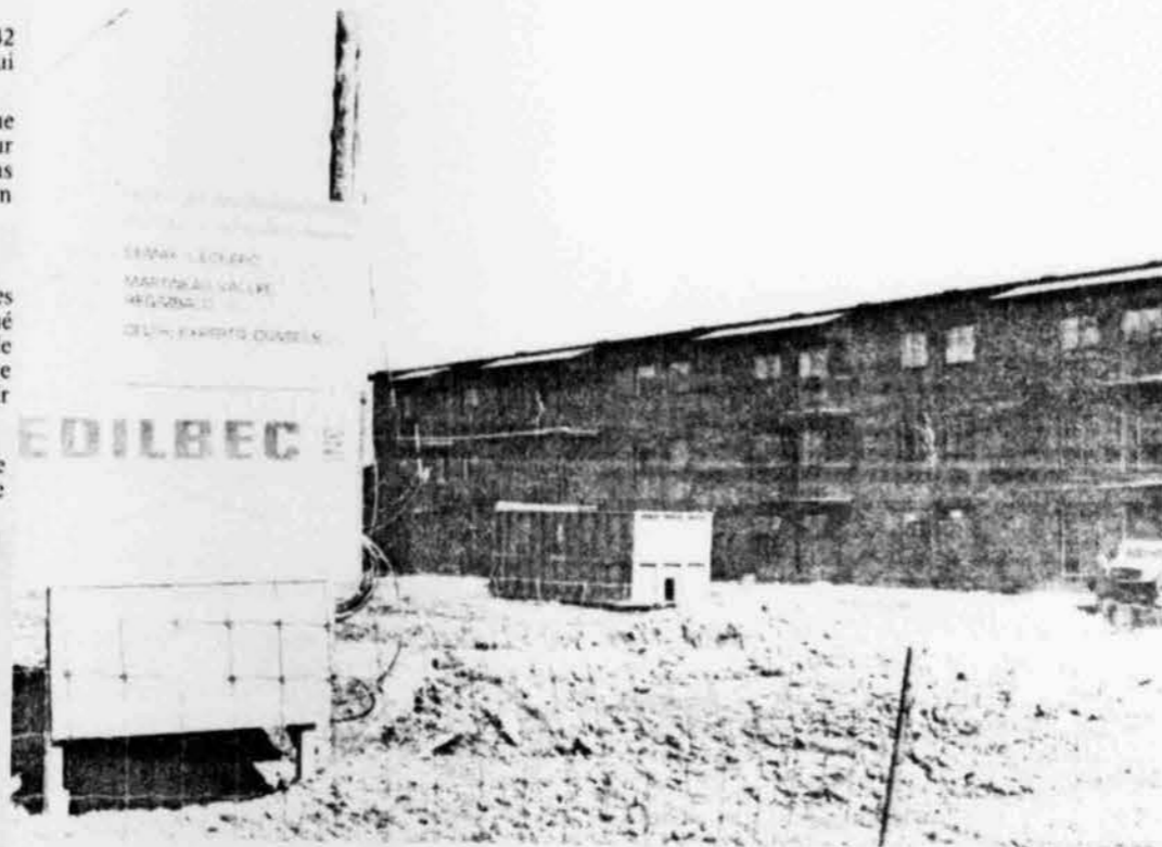
L'extérieur est complètement terminé, il ne reste que l'aménagement paysager. Les travaux s'intensifient présentement à l'intérieur.
