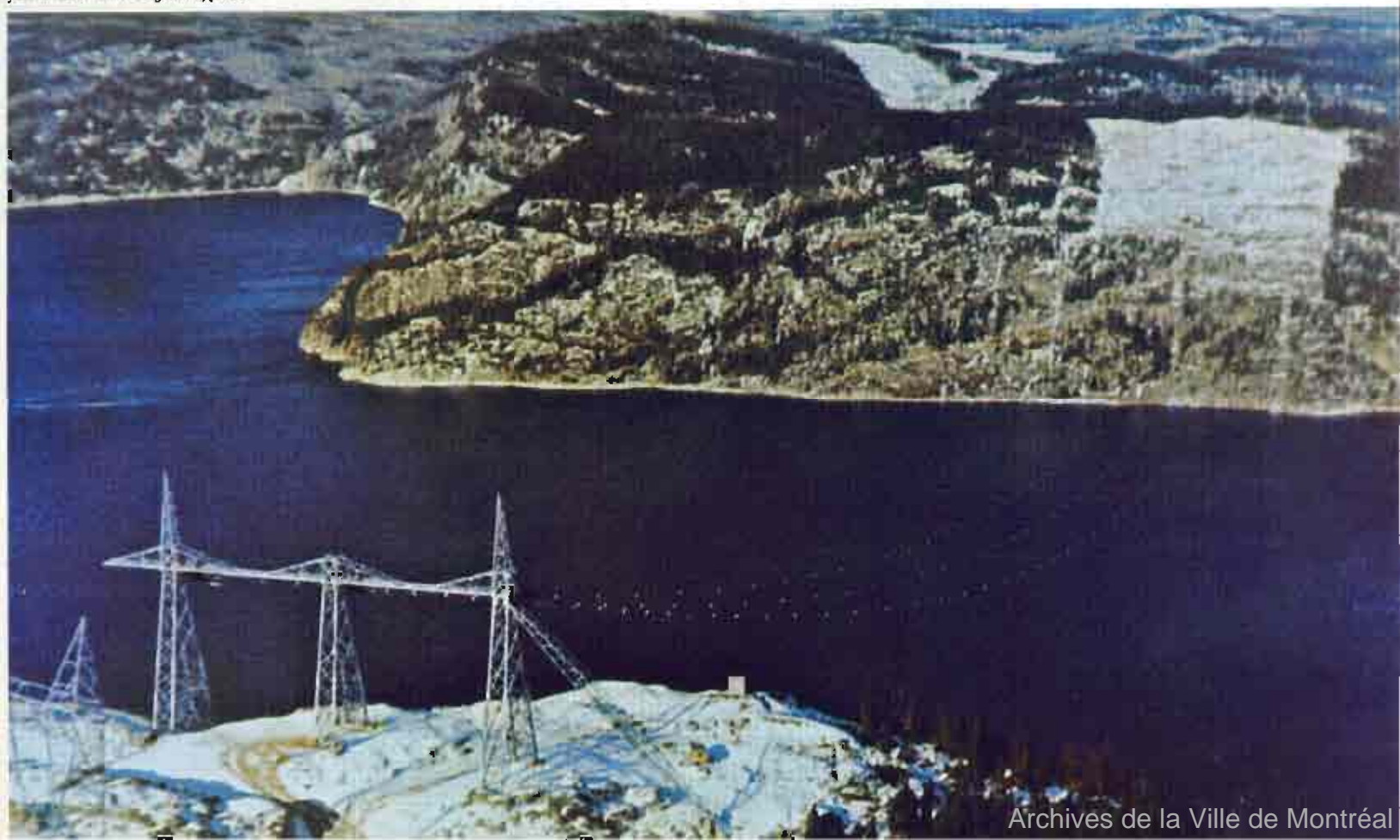
La traversée de la rivière Saguenay • Saguenay River crossing • El paso del río Saguenay • La traversata del fiume Saguenay • Die Hochspannungsleitung führt über den Saguenayfluss.
