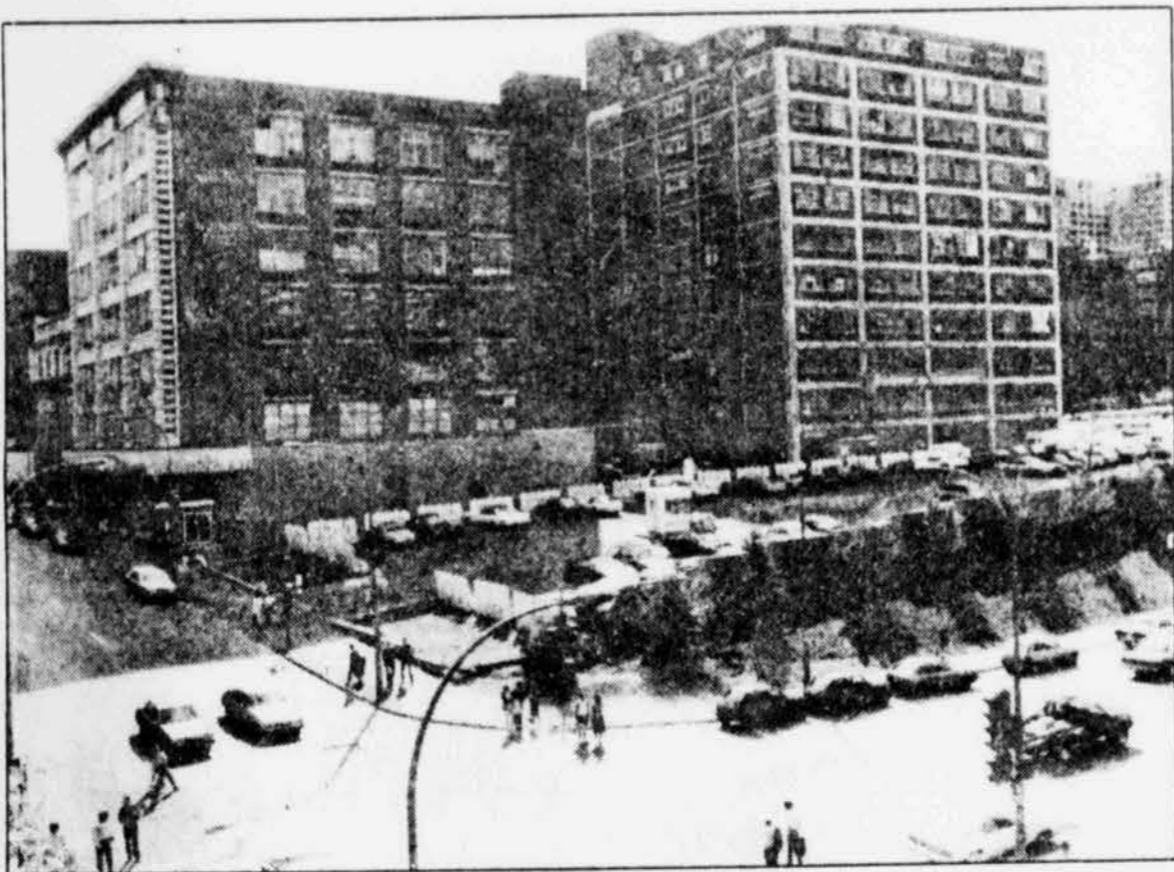
C'est sur ce quadrilatère, sis entre les rues Jeanne-Mance et Bleury, à l'ouest de la Place des Arts, que sera construit un immeuble résidentiel de 250 logements. photo P.H. Talbot, LA PRESSE
