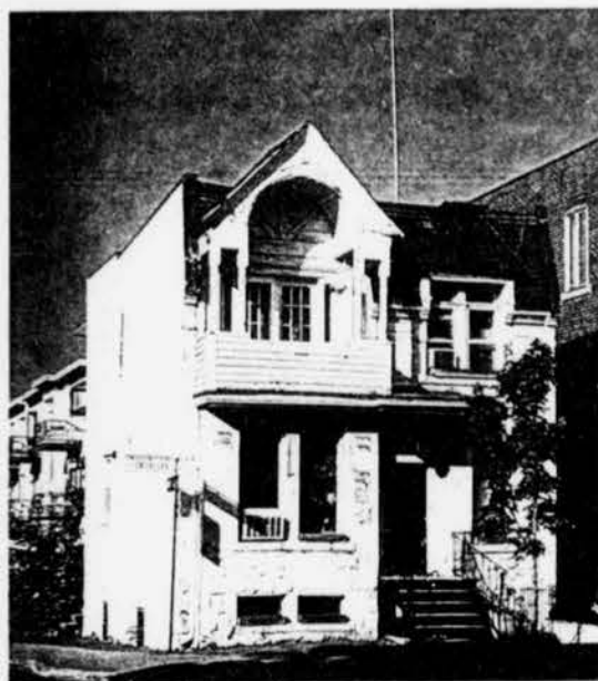
25. 5350, rue Decelles Maison bourgeoise construite vers 1900. Le toit en fausse mansarde comprend un pan fortement incliné vers la rue et une partie arrière en pente douce. Ce mode de construction fut, semble-t-il, très populaire dans l'ancien village de Côte-des-Neiges, site actuel du parc Jean-Brillant.
