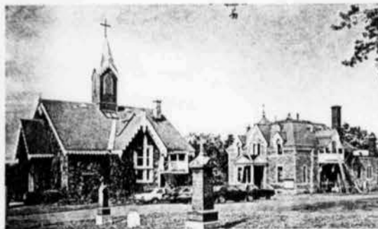
24. À droite, bâtiment administratif du cimetière Notre-Dame-des-Neiges. Le recouvrement du brisis est en feuillards de tôle.
