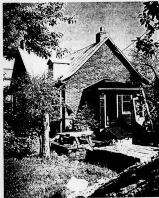
20. Maison de ferme 2875, chemin Bedford.
