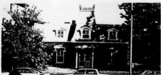
23. Chemin de la Côte Sainte-Catherine La pente du terrasson est faible et difficilement perceptible, celle du brisis est légèrement gaibée. Le recouvrement du brisis est en bardeaux d'asphalte.
