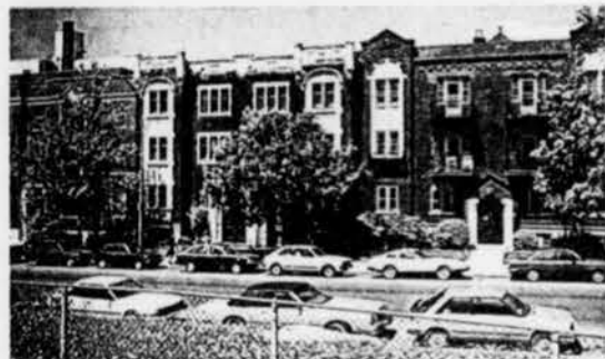
37. 2201, boulevard Edouard Montpetit. L'édifice comprend de six à douze logements. L'ornementation est réalisée au moyen de matériaux de couleur contrastante — linteaux, bandes verticales ou horizontales, médaillons. L'entrée se fait parfois imposante, soulignant le caractère prestigieux de l'édifice.
