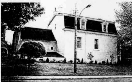
22. 3600, rue Kent La maison Roy, cachée derrière un édifice commercial. Le toit en mansarde est formé de deux pentes sur le même versant, la pente supérieure est appelée terrasson et la pente inférieure, brisis. Le recouvrement de la toiture est en bardeaux à motifs.
