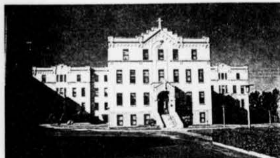
11. Ancien pensionnat Notre-Dame-de-Sainte-Croix 5790, chemin de la Côte-des-Neiges
