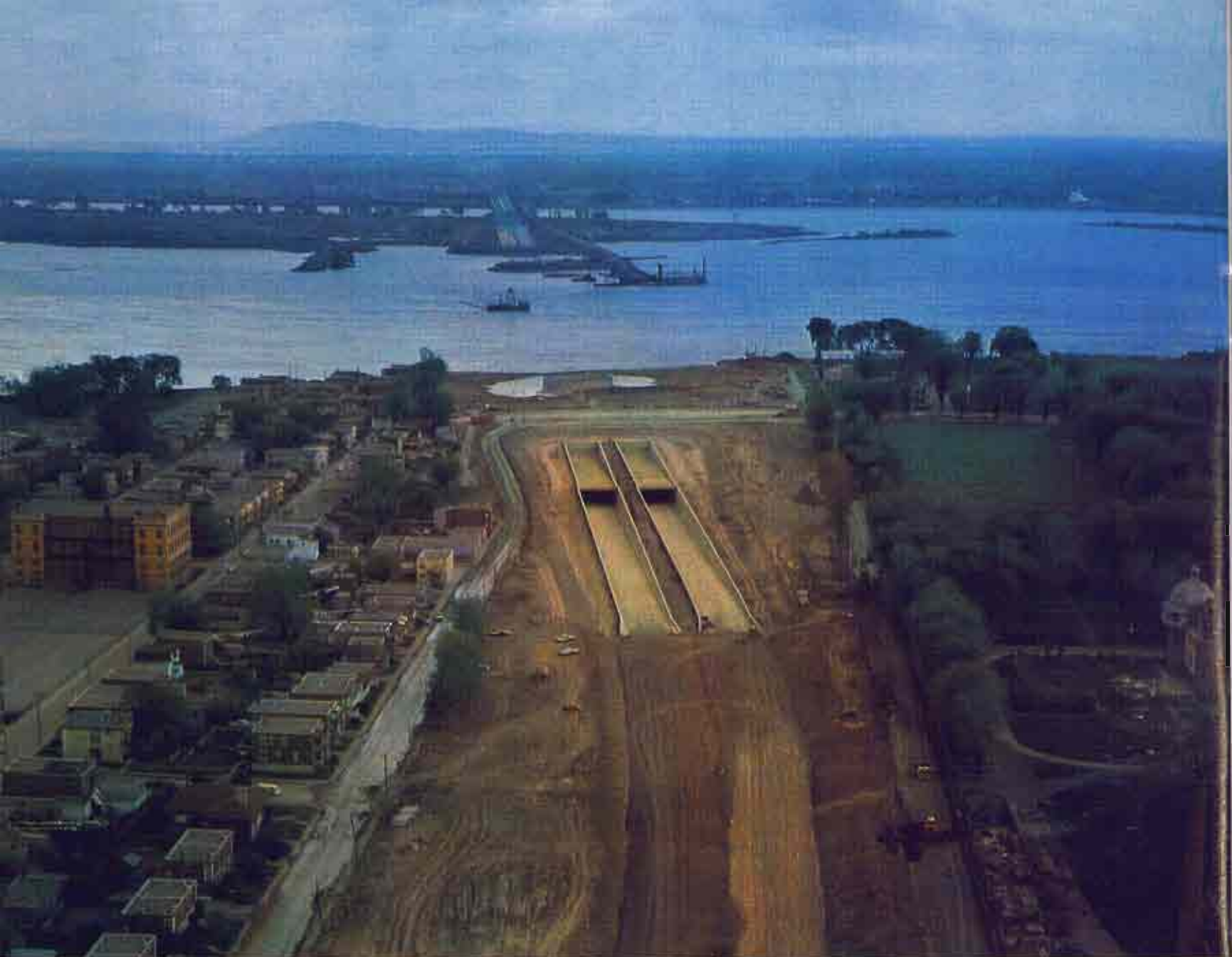
L'entrée du tunnel qui passe sous le Saint-Laurent • Approach to the tunnel-bridge complex Louis-Hippolyte Lafontaine • La entrada del túnel que pasa bajo el río Saint-Laurent • L'entrata del tunnel che passa sotto il fiume Saint-Laurent • Eingang zum Tunnel unter dem Sankt-Lorenzstrom.
