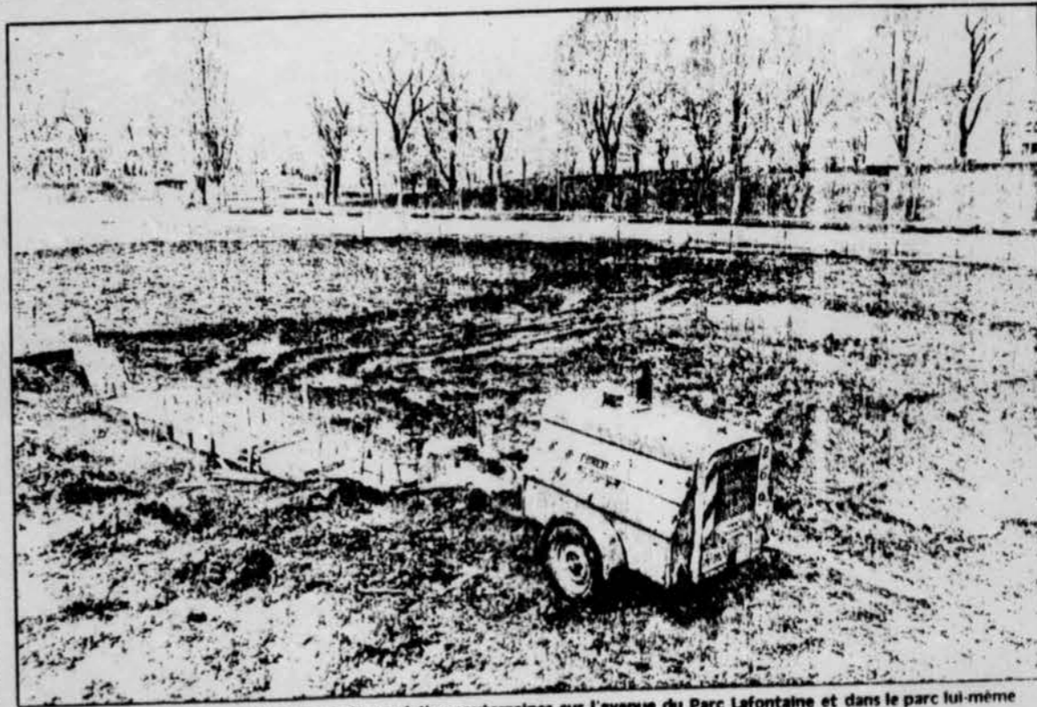
D'importants travaux de remplacement de conduites souterraines sur l'avenue du Parc Lafontaine et dans le parc lui-même retardent le remplissage de l'étang.
