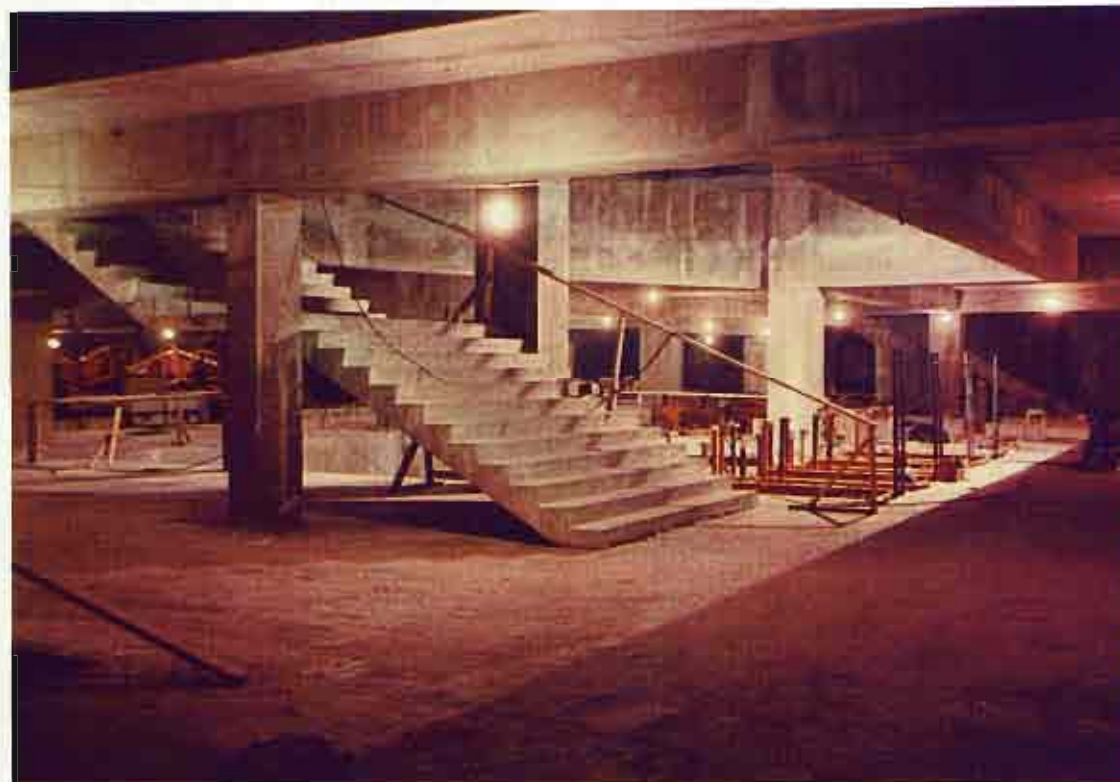
La plupart des 26 stations du Métro seront dotées d'escaliers automatiques • Here is one of 26 stations which will serve Métro • La mayoría de las 26 estaciones del Metro tendrán escaleras automáticas • Il maggior numero delle 26 stazioni della metropolitana sarà dotato di scale mobili • Eine der 26 Untergrundbahnstationen, von denen die meisten mit Rolltreppen ausgestattet werden.
