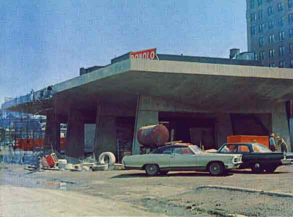
Parachèvement d'une station, au centre de la ville • Downtown station nears completion stage • Trabajos finales de una estación del Metro de Montréal • Al centro della città, una stazione quasi completata • Eine Untergrundbahnstation im Zentrum der Stadt kurz vor der Fertigstellung.
