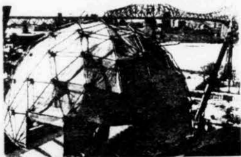
Stranlebus inhabituel à La Ronde. On a procédé, récemment au démontage spectaculaire du Disco-Dome du parc d'amusement. Il a fallu trois grues géantes pour mener à bien cette délicate opération, à 160 pieds au dessus du sol. Ce démontage, et les autres qui suivront au cours des prochains semaines, est le prélude d'une saison qui s'annonce par des changements et nouveautés.
