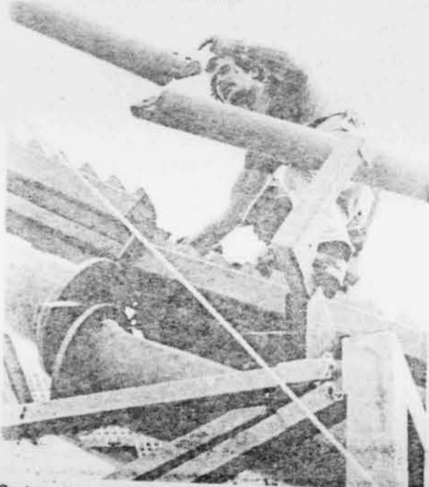
On travaille sans arrêt à la construction de ce Supermanège!
