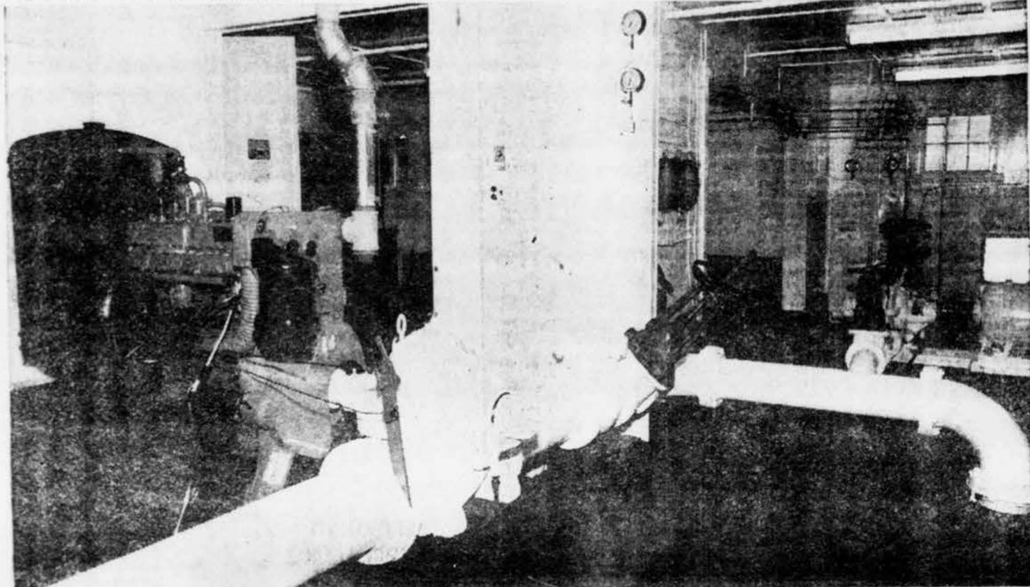
Alimente environ 50% de la cité. 2 pompes de 2,000 et 1,000 gallons par minute. Engin à combustion au cas de panne électrique. Fonctionnement entièrement automatique. Une réalisation de la firme Villeneuve et Gauvin, Ingénieurs-conseils, 366 rue Lafleur, LaSalle, 366-9730.
