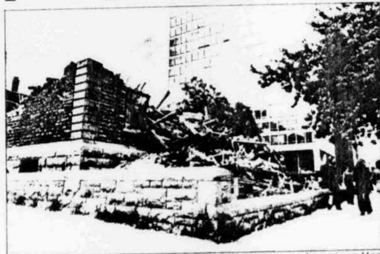
Pour éviter que disparaissent d'autres édifices comme la maison Van Horne, démolie en 1973, le Comité sur la préservation du patrimoine immobilier Montréalais suggère de conférer à la Ville des pouvoirs plus grands de surveillance et de contrôle.
