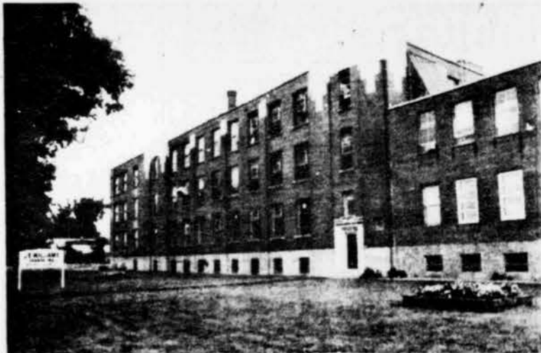
Le bâtiment de la J.B. Williams, boulevard LaSalle, sera détruit d'ici peu pour faire place à des maisons unifamiliales. (Photo Bob Pichette 366-7417)
