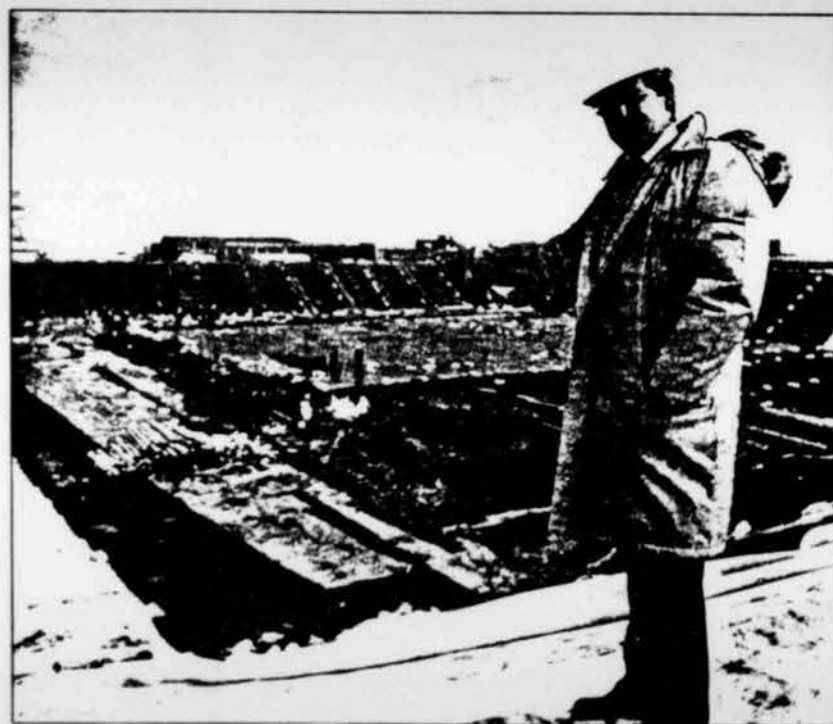
À l'arrière-plan, vue de la cellule d'enfouissement au chantier de la LaSalle Coke.
