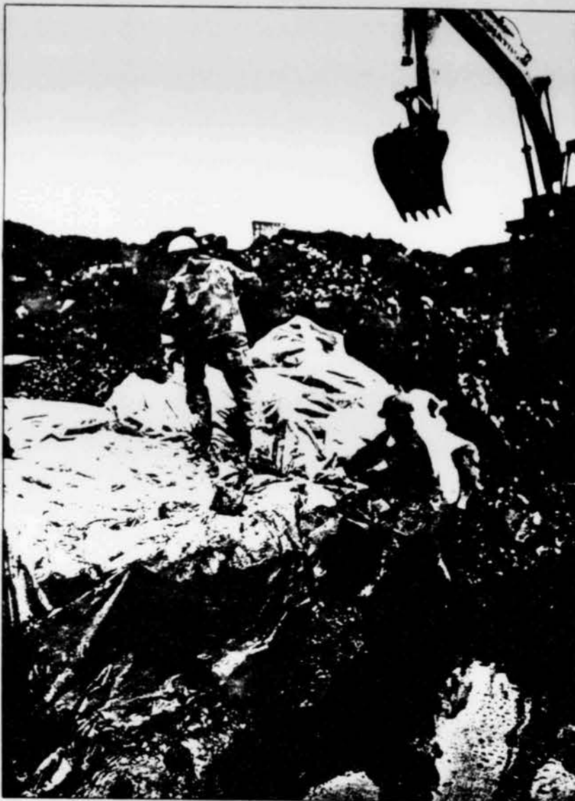
Travaux de restauration en cours à la célèbre «marre à goudron» de Rivières-des-Prairies.
