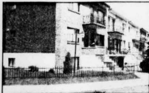
Contrairement à d'autres propriétaires, M. Cyr ne veut pas quitter sa maison pour la durée des travaux.
