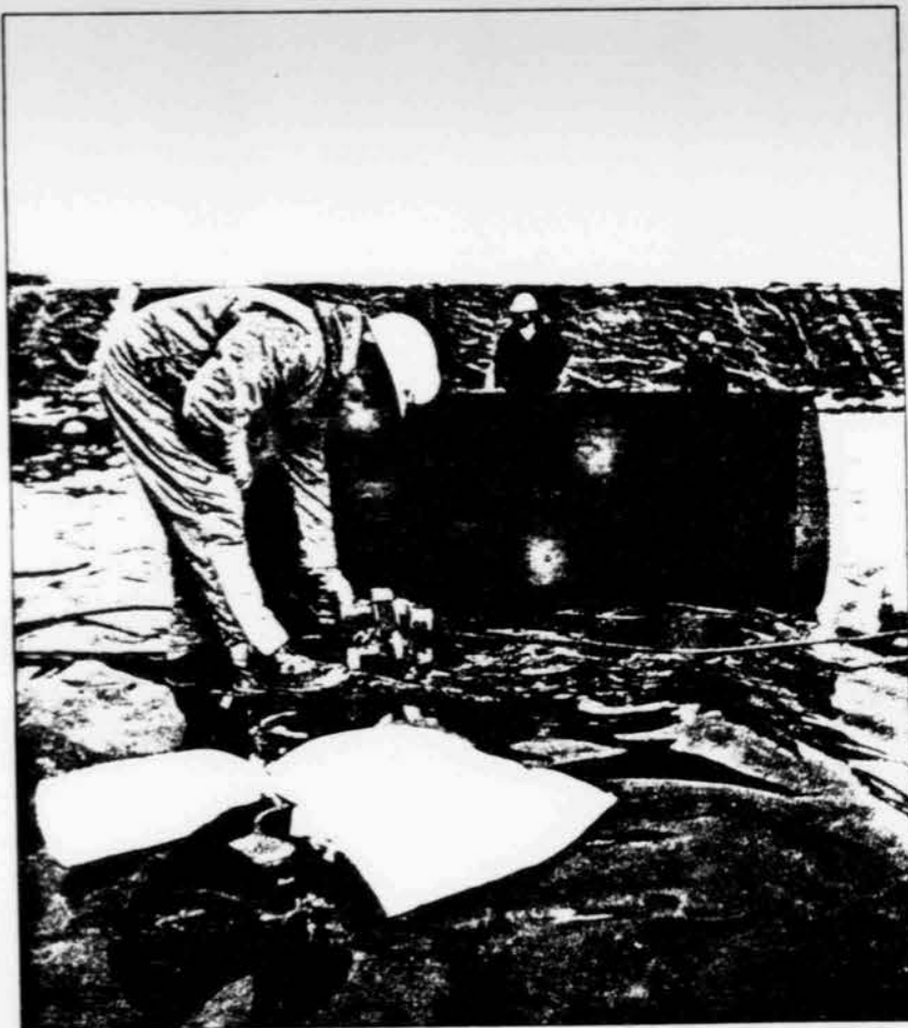
Scellement des joints de la membrane d'une cellule d'enfouissement qui recevra les sols contaminés.
