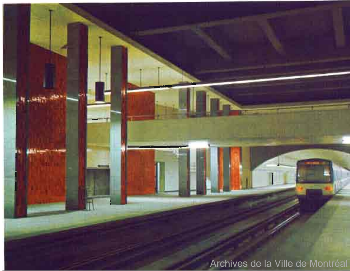
Chacune des stations se distingue par une architecture particulière. Ici, la station Rosemont • Tunnels are widened to 44 feet for distance of 500 feet at each station. Rosemont station is shown here • Cada una de las estaciones posee una arquitectura particular. Aquí vemos la estación Rosemont • Ogni stazione si distingue per uno stile architettonico particolare. Qui, la stazione Rosemont • Jede einzelne Station weist eine besondere Ausgestaltung auf. Ansicht der Rosemont-Station.
