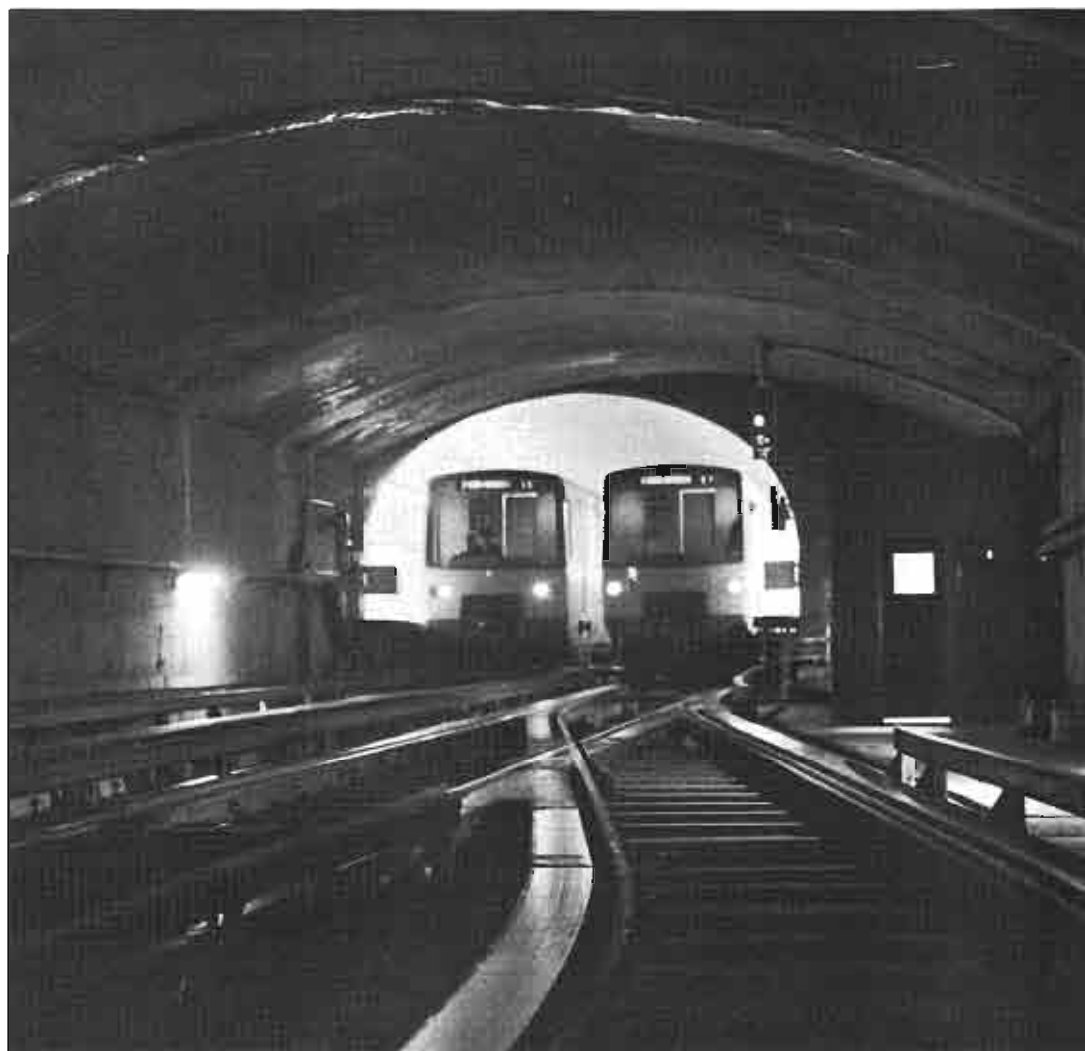
Les ingénieurs ont percé un seul tunnel pour les deux voies • Single two-way tunnels, instead of double-barrelled tunnels used elsewhere, helped cut cost • Los ingenieros han abierto un solo túnel para las dos vías • Gli ingegneri hanno costruito un solo tunnel per i due percorsi • Statt der üblichen jeweils zwei Tunnel hat die Montrealer Metro jeweils einen Tunnel mit Gleisen in beiden Richtungen.
