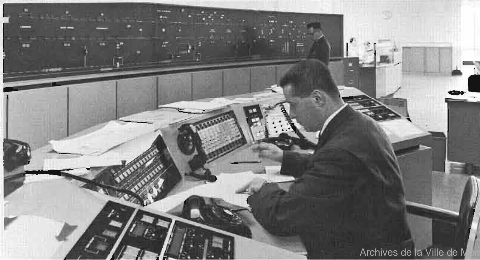
Un bâtiment, près de la station Berri-de Montigny, abrite le poste de commande centralisée • Métro's central control is housed in special building near Berri-de Montigny station • Cerca de la estación Berri-de Montigny, el edificio donde funciona la central de control del metro • La stazione di comando centrale della metropolitana si trova in un edificio speciale nei pressi della stazione Berri-de Montigny • Die Hauptkontrollanlage befindet sich in einem Gebäude in der Nähe der Berri-de Montigny-Station.
