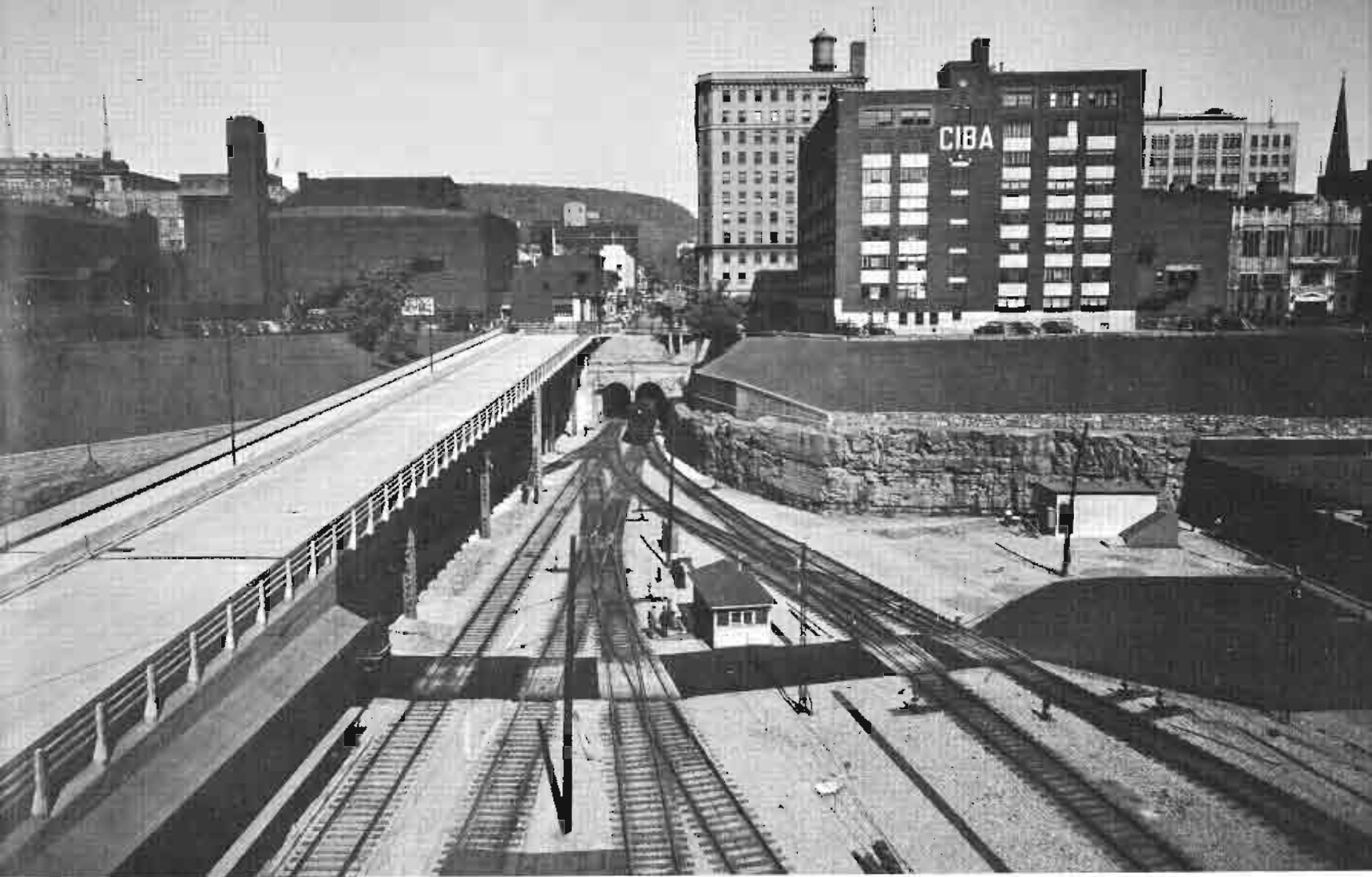
Cette photo, prise avant la construction de l'immeuble de la Place Ville-Marie, montre l'entrée du tunnel • This is how tunnel entrance appeared from Dorchester Bridge prior to construction of Place Ville-Marie • Esta fotografía, tomada antes de construirse el edificio de la Place Ville-Marie, muestra la entrada del túnel • L'entrata della galleria ferroviaria prima della costruzione della Place Ville-Marie • Tunnelingang, aufgenommen vor dem Bau des Place Ville-Marie.
