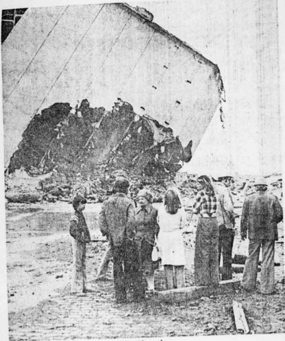
Un des entrepôts sur le point de s'écrouler.
