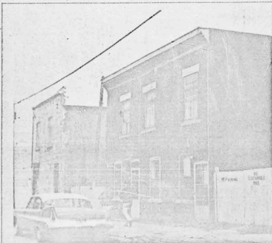
Des immeubles délabrés, vétustes, près de la rue Chatam, dans le secteur "B" du projet "La Petite Bourgogne". (Photo Gino Salotti)
