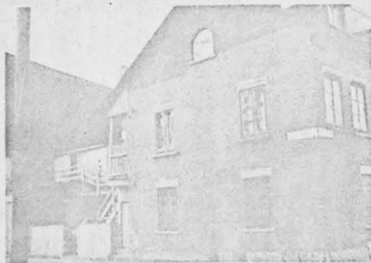
Déjà les habitants du 2e étage ont fui ce vieux immeuble tandis que ceux de l'étage inférieur l'habitent encore. Il faudrait des mesures énergiques pour rénover toute "la petite Bourgogne". (Photo Gino Salotti)
