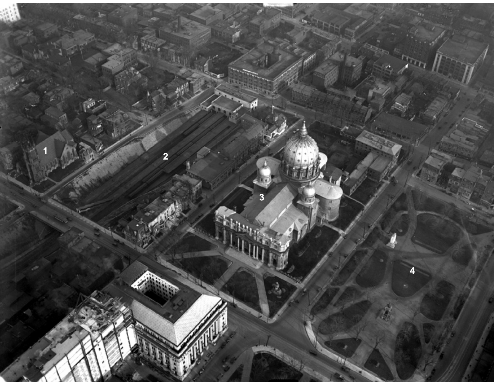
65 1927. De gauche à droite sur la rue Dorchester : 1. église, 2. la tranchée dans la trame urbaine des rames de train du Canadien Nord, 3. la cathédrale Saint-Jacques, 4. le square Dominion. BanQ, E21,S110,SS1,SS51,PX23
