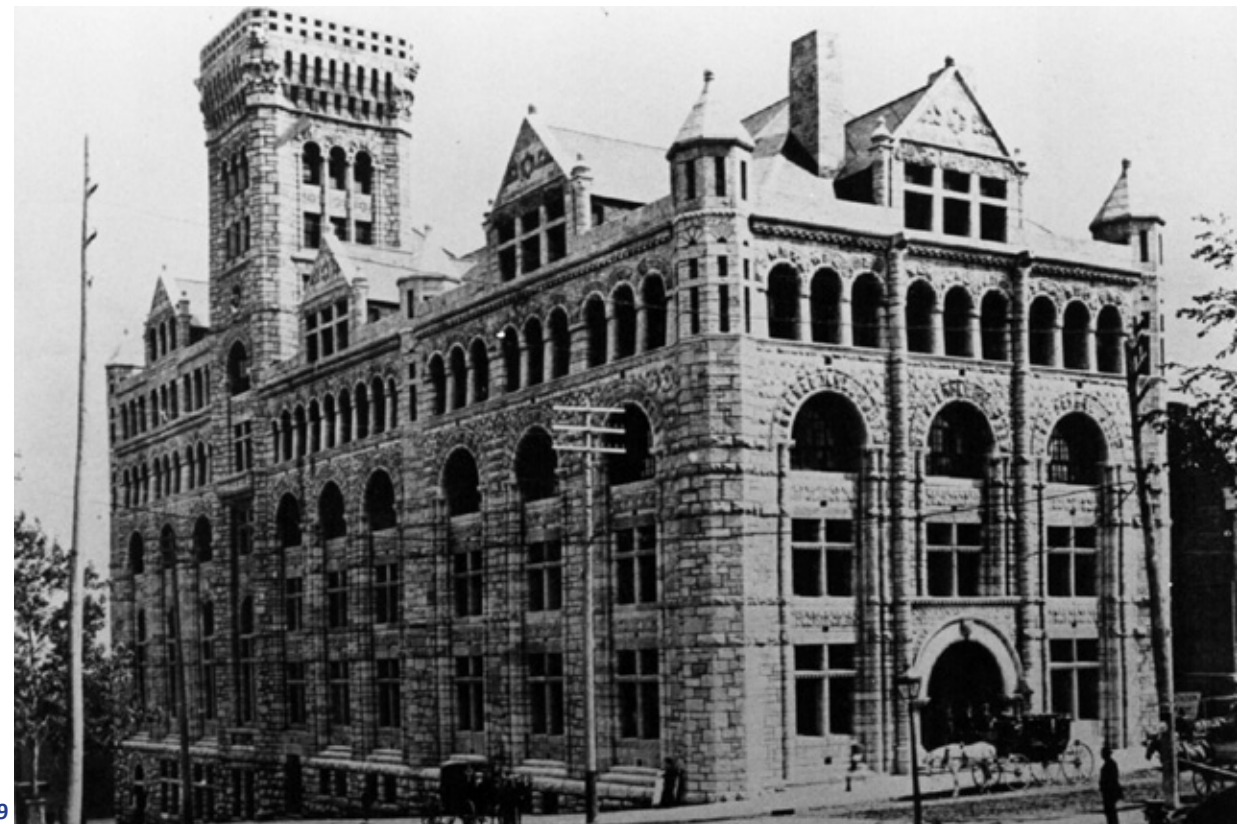
39 1898. La première phase de construction de la gare Windsor à l'angle des rues Windsor et Osborne. Tiré de Art Work on Montréal .
