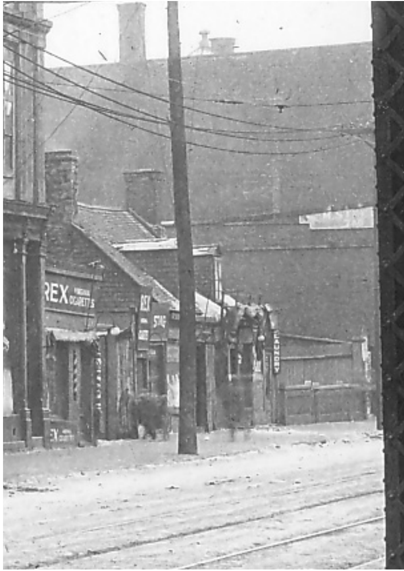
28 janvier 1927. Exemple de maisons de faubourg dans le secteur. Ces maisons sont situées à l'intersection des rues Notre-Dame et de l'Aqueduc. AVM. VM98-Y_2P037. (détail)
