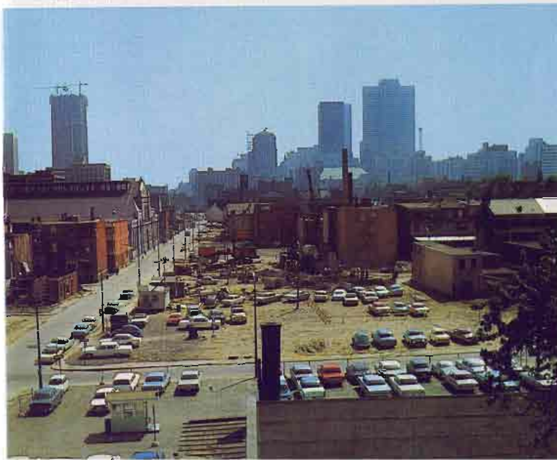
Pour faire place à la route transcanadienne, qui doit traverser Montréal d'ouest en est, de vieux immeubles sont démolis au cœur de la ville ● Vitre St. buildings are being demolished to make way for Trans-Canada Highway through downtown area ● Demolición de edificios en la calle Vitre para facilitar a través del centro urbano de Montreal el paso de la carretera transcontinental ● Vecchi edifici di via Vitre vengono demoliti per far posto all'autostrada trans-canadese che andrà dall'est all'ovest di Montreal ● Um für die Trans-Kanada-Autostrasse Platz zu machen, die durch Montreal verlaufen soll, werden alte Gebäude im Herzen der Stadt abgerissen.
