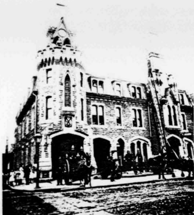
Une échelle d'incendie Laforce Langevin, Service des incendies de Montréal. Collection Livernois. (PA-24054)
