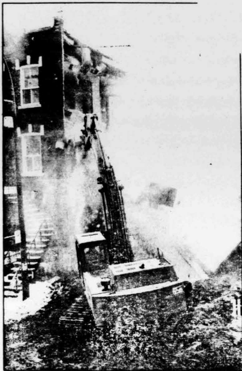
Photo Normand JOLICOEUR Après quelques coups de pelle, l'immeuble a été éventré.
