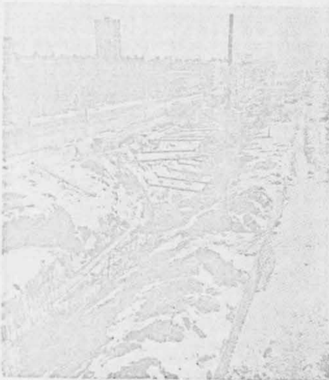
Décarie, c'est encore le tohu-bohu, mais la construction des murs de soutènement avance rapidement.
