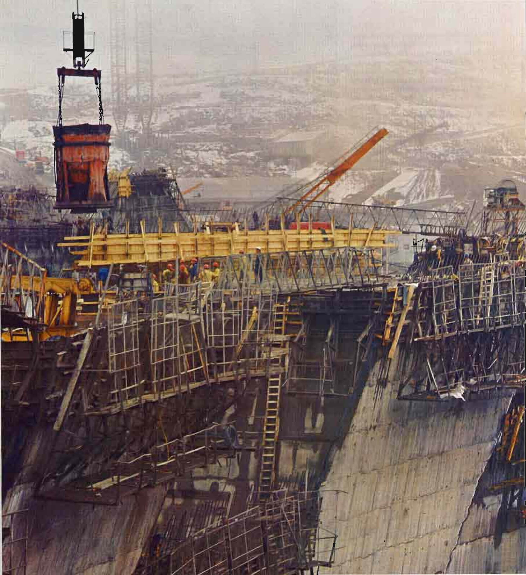
Le barrage "Manic 5" sur la Manicouagan est l'un des ouvrages gigantesques de l'Hydro-Québec • Manicouagan 5, a vital part of a remarkable new hydro-electric power complex in Quebec • La central "Manicouagan 5", obra gigantesca de la compañía eléctrica Hydro-Quebec • Lo sbarramento "Manic 5" sul Manicouagan é uno dei giganteschi lavori realizzati dall'Hydro-Québec • Der Staudamm "Manic", Teil eines gigantischen Kraftwerkprojektes am Manicouaganfluss in der Provinz Quebec.
