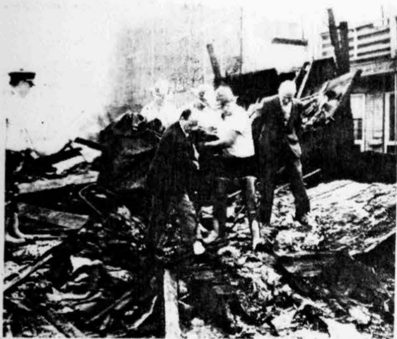
Le corps d'une des deux femmes est sorti des débris.
