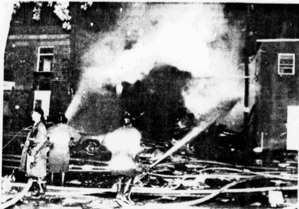
La déflagration a été si puissante que les pompiers n'ont pu sauver l'immeuble, qui s'est finalement écroulé.
