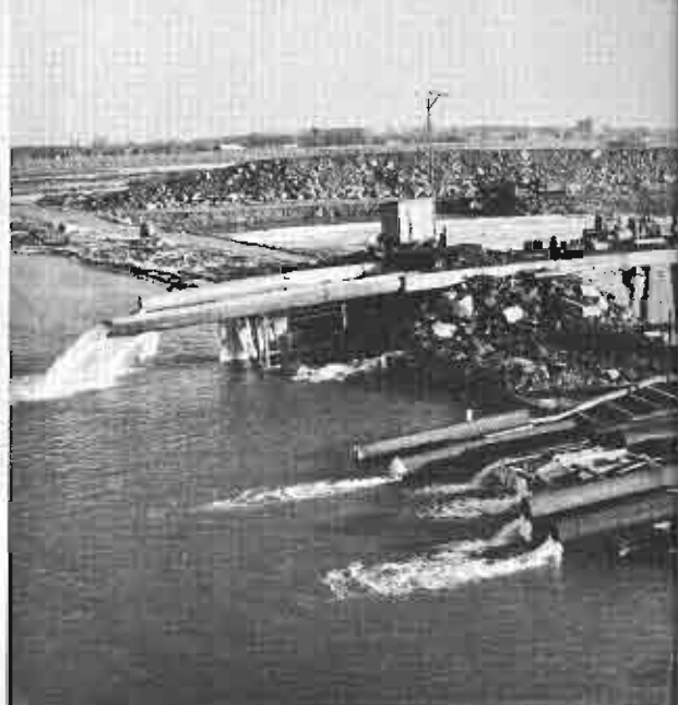
La terre, arrachée du lit du Saint-Laurent, est acheminée par de longues canalisations vers les secteurs prioritaires du remblayage ● From the bed of the St. Lawrence, fill is sucked up and distributed to new islands ● La tierra arrancada del lecho del San Lorenzo es conducida para formar las dos nuevas islas ● Lunghe canalizzazioni conducono la terra del letto del San Lorenzo a formare le nuove isole ● Aus dem Flussbett des Sankt-Lorenzstromes wird Erde gehoben, mit der die neugeschaffenen Inseln aufgefüllt werden.
