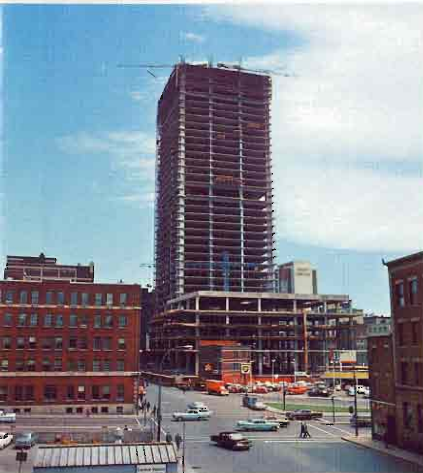
Place Victoria, chantier de la nouvelle Bourse de Montréal qui sera terminée en 1965 ● Place Victoria, site of the new Montreal and Canadian stock exchanges, scheduled for completion in 1965 ● Place Victoria, construcción del nuevo edificio para la Bolsa de Montreal, que se verá terminado para 1965 ● La costruzione di Place Victoria, sede della nuova borsa di Montreal, sarà terminata nel 1965 ● Der im Bau befindliche Place Victoria, Sitz der neuen Börse von Montreal, der 1965 vollendet werden wird.
