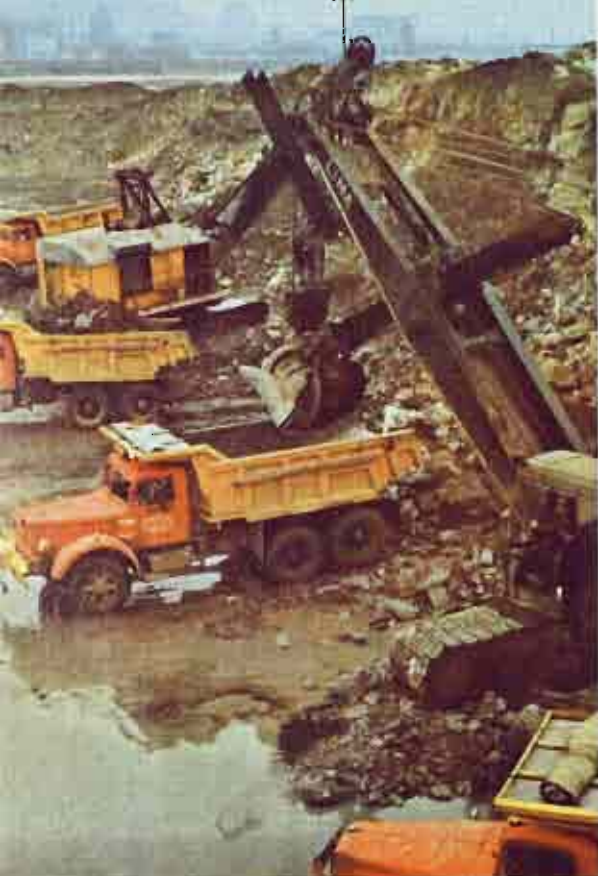
Treize millions de tonnes de terre et de pierre auront été transportées en moins d'un an • Trucks, 100, are busy in island-creation • 13 millones de toneladas de tierra y piedras para la creación de las islas • Si trasportano tredici milioni di tonnellate di terra e di pietra all'anno • Lastwagen sind ebenfalls bei den Arbeiten zur Schaffung der neuen Inselgelände eingesetzt.
