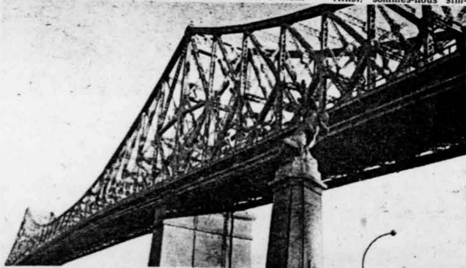
Le pont Jacques-Cartier: La ville voudrait le raccorder à l'autoroute est-ouest ou, simplement en refaire les approches.
