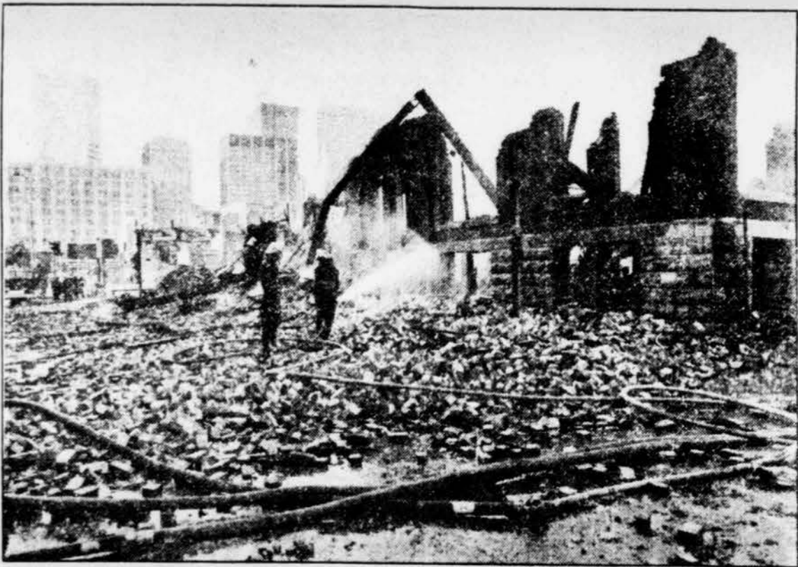
Les murs de briques de l'édifice dévasté sont tous tombés dans les rues avoisinantes.
