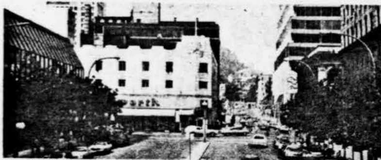
Une fois le "Woolworth" et l'immeuble derrière démolis au printemps prochain, Montréal pourra transformer l'avenue McGill College en un large boulevard (comme le tronçon déjà existant à l'avant-plan) qui débouchera sur l'entrée principale de l'université McGill que l'on aperçoit au fond.
