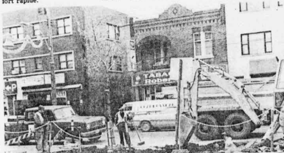
Rapidement, nos conseillers municipaux ont répondu à la demande de l'Association des Marchands du boulevard Monk et ont permis l'accès du stationnement sur le boulevard. Les travaux ont également été exécutés dans un court délai.
