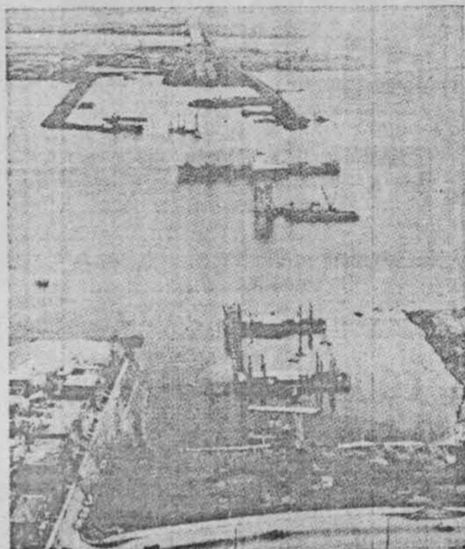
L'ensemble du chantier du pont-tunnel apparaît ci-dessus, vu du côté nord du fleuve. Ci-dessous, autre vue d'ensemble du chantier, cette fois de la rive sud. On distingue le contour de la cale sèche où furent construits les éléments.
