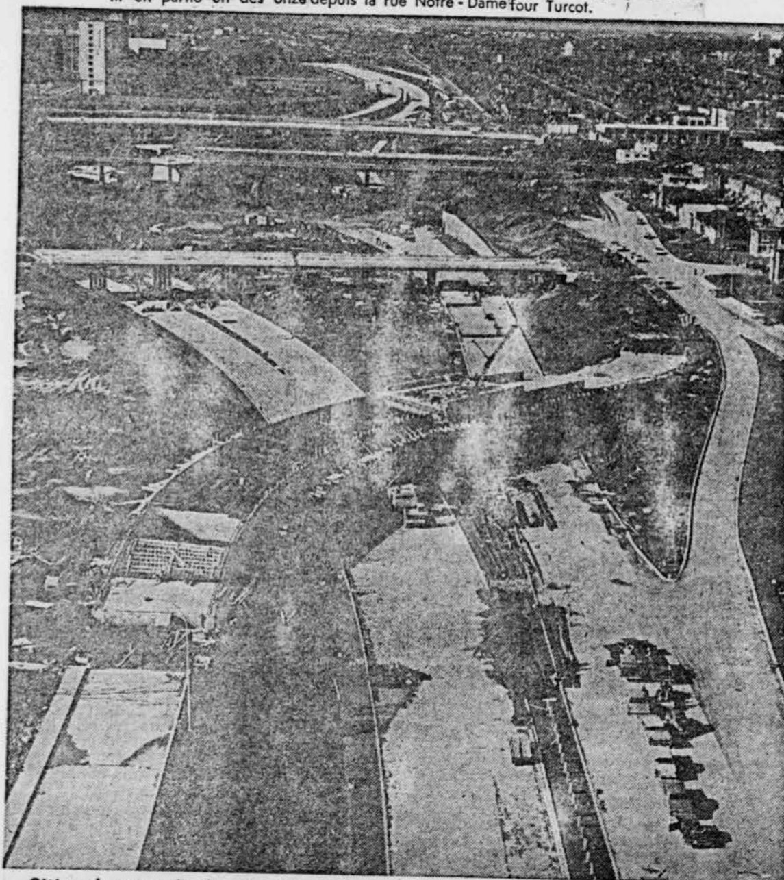
Côté nord, on travaille d'arrache-pied afin de compléter en temps la construction du carrefour Hochelaga.
