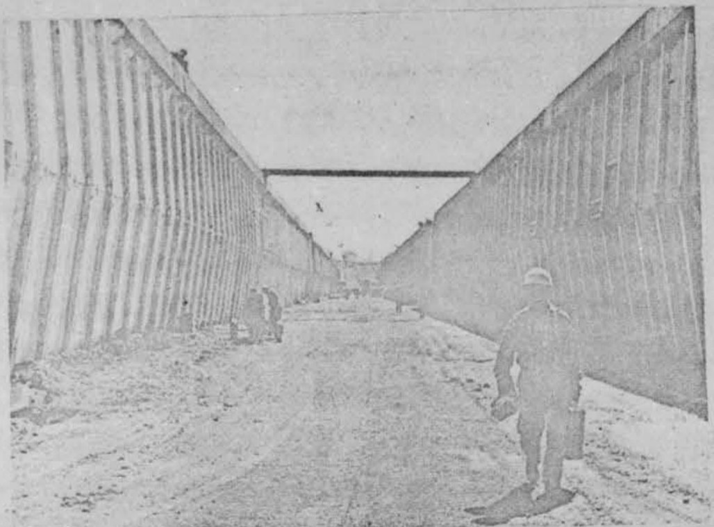
Les sections ont été enduites de feuilles goudronnées et sont protégées par de lourds madriers, montés verticalement.
