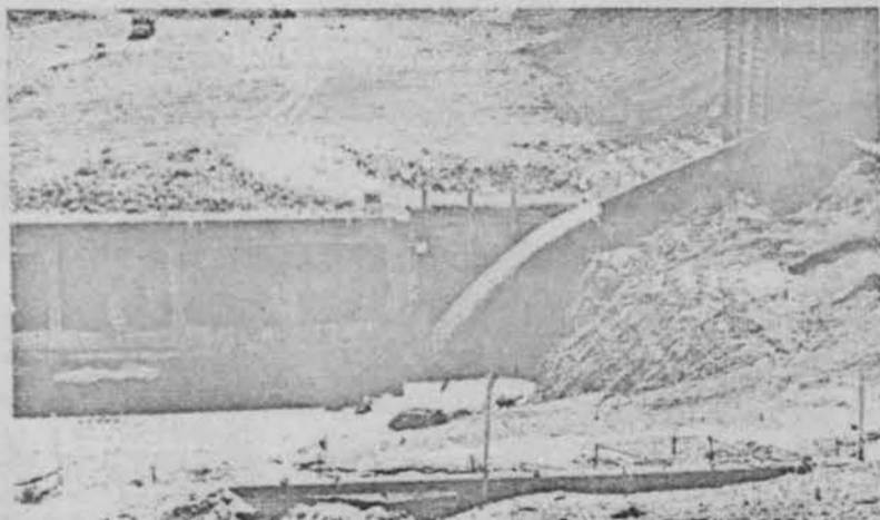
L'eau se précipite au fond de la cale sèche. Il faudra huit jours et autant de nuits pour noyer la partie du tunnel déjà achevée.
