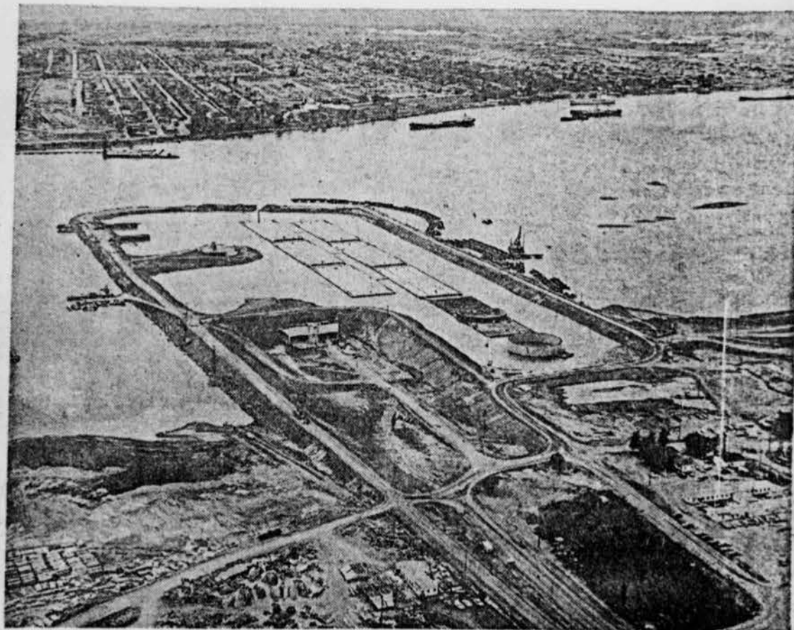
VOICI L'ASPECT qu'offrait le chantier de construction du tunnel à la fin de mai 1963. La cale avait été inondée et les sept éléments préfabriqués attendaient d'être amenés vis-à-vis leur emplacement définitif au milieu du fleuve. On aperçoit aussi l'entrée des deux tubes de circulation du côté sud.
