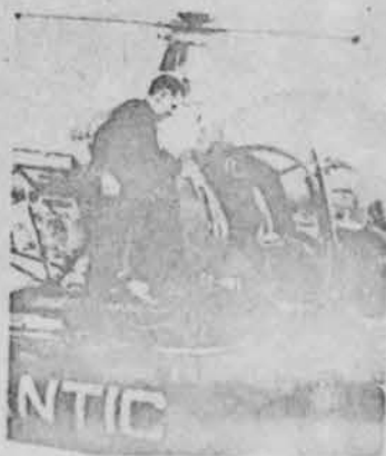
LE MINISTRE des travaux publics, M. Jean-Paul Deschâtelets, au moment de monter à bord de l'hélicoptère qui lui a permis, hier matin, d'examiner l'estacade en construction, près de l'île Champlain.
