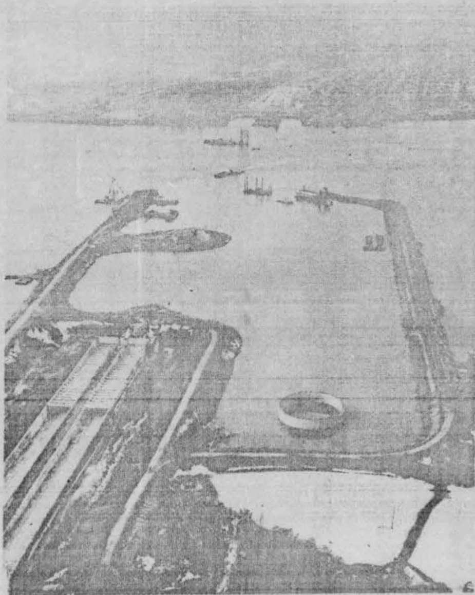
Le chantier du pont tunnel Louis-Hippolyte La Fontaine vu de la rive sud. Au loin, nous apercevons le site du tronçon de la transcanadienne sur l'île de Montréal.
