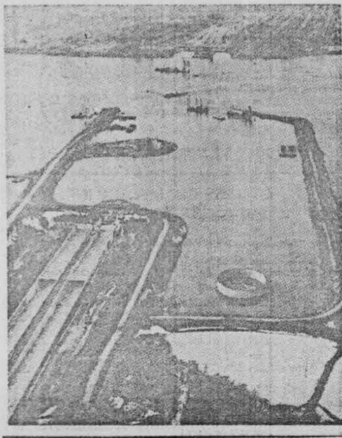
L'ensemble du chantier du pont-tunnel apparaît ci-dessus, vu du côté nord du fleuve. Ci-dessous, autre vue d'ensemble du chantier, cette fois de la rive sud. On distingue le contour de la cale sèche où furent construits les éléments.
