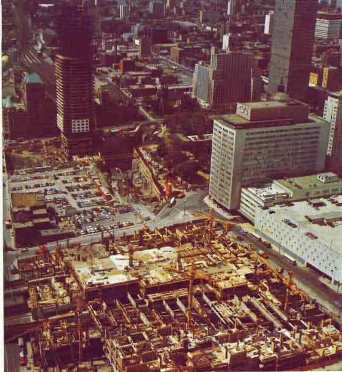
Le chantier de la Place Bonaventure et, à l'arrière-plan, l'hôtel Château Champlain en construction • Place Bonaventure takes shape in foreground and Château Champlain behind it • La Place Bonaventure toma forma y, en segundo plano, el hotel Château Champlain en construcción • Il cantiere della Place Bonaventure e, nello sfondo, l'hôtel Château Champlain in costruzione • Ein neuer Gebäudekomplex, "Place Bonaventure" ist im Entstehen begriffen, im Hintergrund das im Bau befindliche Hotel Château Champlain.
