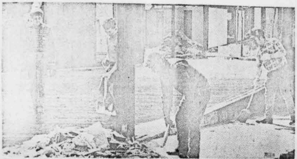
Dans le Carrefour international c'est l'opération nettoyage. En effet on vient de démolir quelques boutiques pour en agrandir d'autres.
