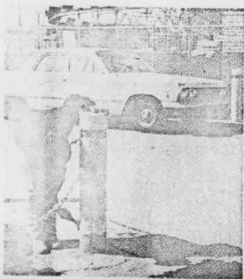
Cette rue de LA RONDE a souffert de l'hiver. On refait le ciment.
