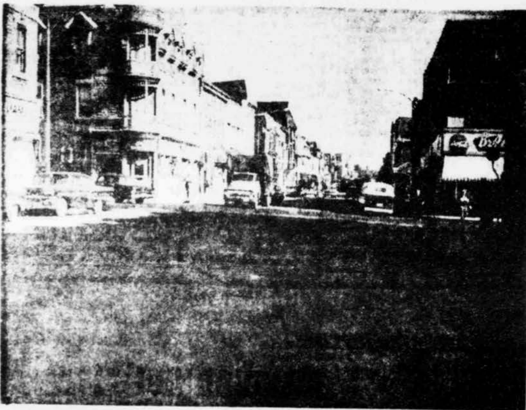
Après les travaux.
