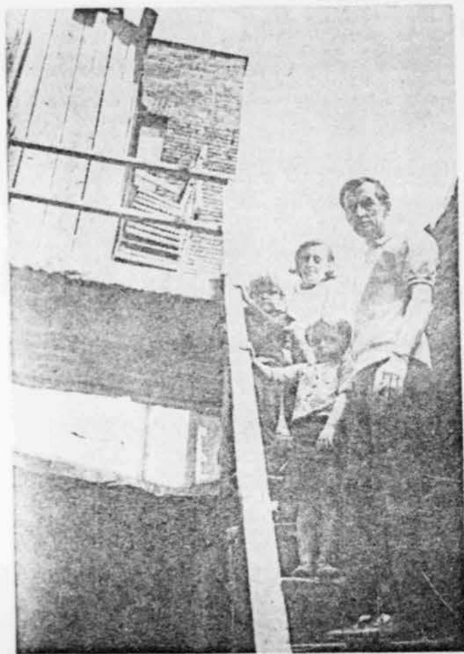
Attend-on des pertes de vie pour condamner cet escalier branlant qui mène au 3e étage ? M. et Mme JOSEPH POTHIER et deux de leurs enfants, LOUISE et ANDRE, nous ont démontré leur talent d'acrobates pour y grimper. (Photos Gilles Corbeil)
