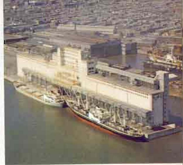
Le plus gros élévateur à grain au monde domine les installations portuaires • Grain elevator is largest in world • El elevador de granos más grande del mundo domina las instalaciones portuarias • Nel porto: il più grande elevatore di grano del mondo • Grösster Getreidespeicher der Welt.
