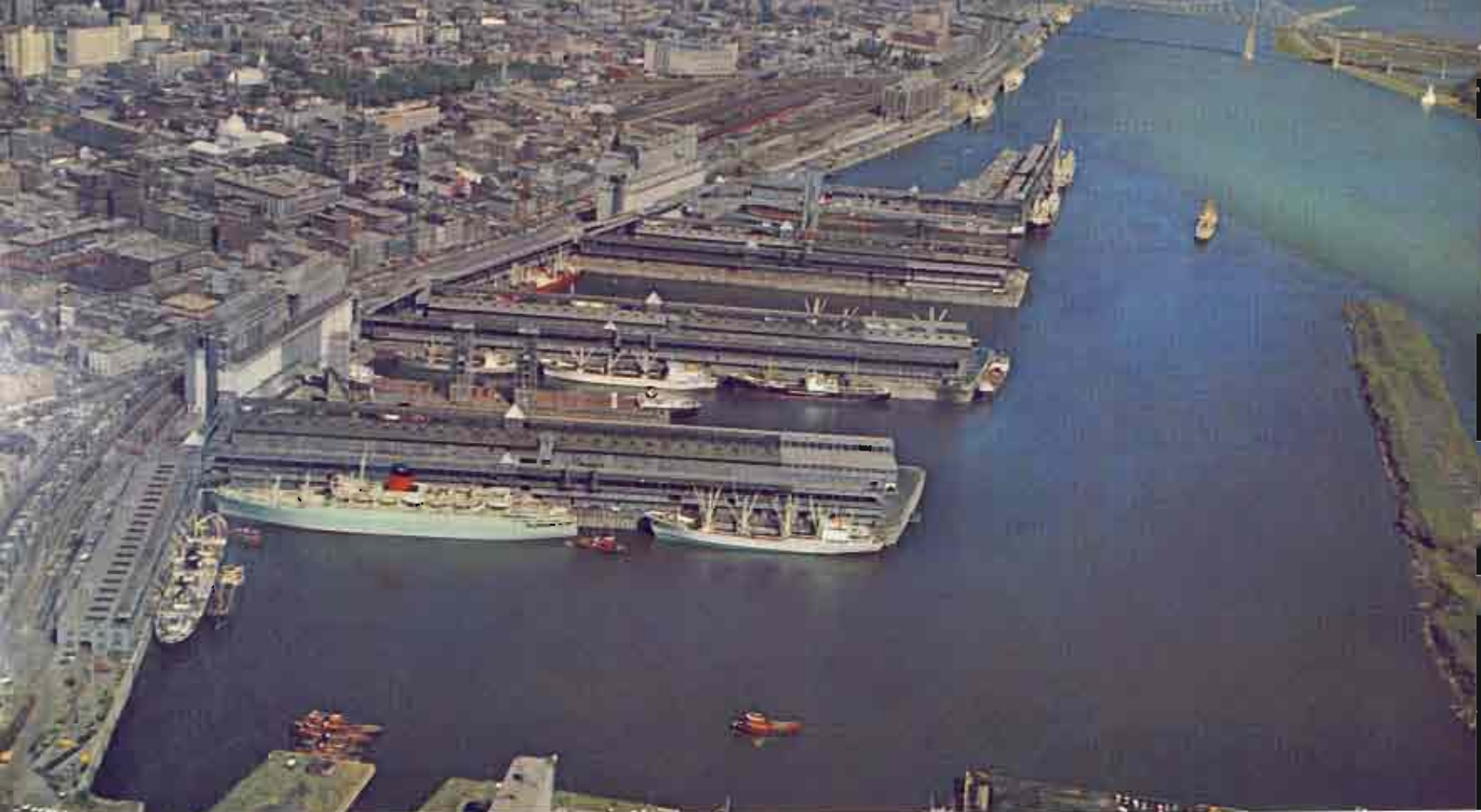
Vue aérienne de la section est du port de Montréal • Aerial view of eastern section of Port of Montreal • Vista aérea de la parte Este del puerto de Montreal • La regione orientale del porto di Montreal • Luftansicht des östlichen Teiles des Montrealer Hafens.
