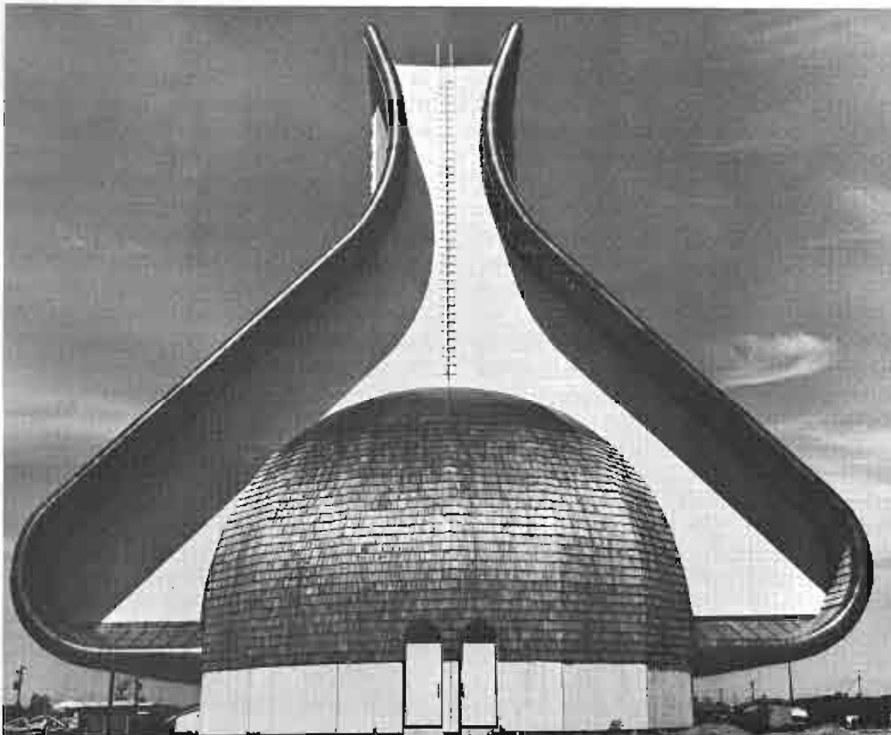
L'immense toit de l'église Notre-Dame-des-Champs est revêtu de bardeaux de bois qui réfléchissent le soleil • Immense bulging roof of Notre-Dame-des-Champs Church is covered with wooden shingles, glistening golden in the sun • El inmenso techo de la iglesia Notre-Dame-des-Champs está revestido de tejas de madera que reflejan el sol • Assicelle di legno, che brillano come l'oro, rivestono il tetto immenso della chiesa di Notre-Dame-des-Champs • Die Holzschindeln auf dem riesigen Dach der Notre-Dame des Champs Kirche erglänzen golden im Sonnenlicht.
