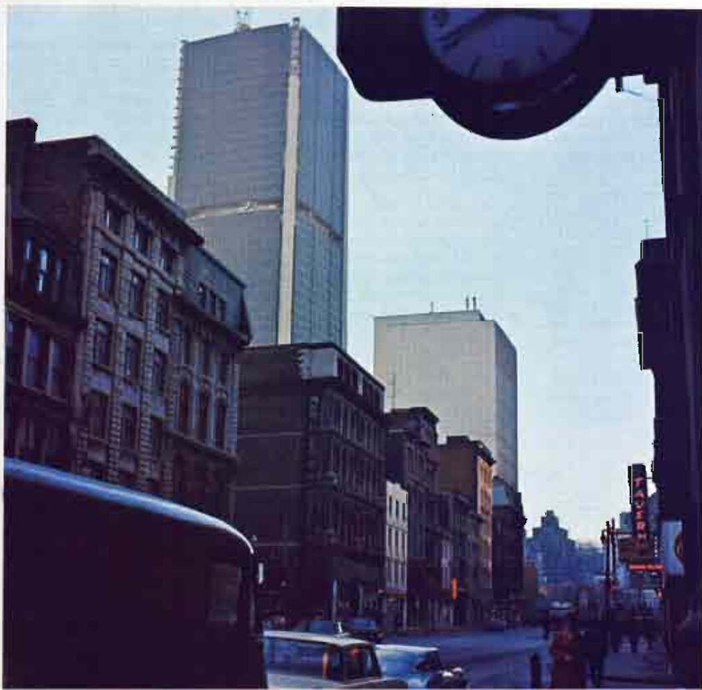
Au delà du vieux quartier des affaires, se profilent les immeubles modernes de Montréal • Old commercial area is dwarfed by modern skyscrapers • Más allá del viejo barrio comercial se perfilan los modernos edificios de Montreal • I grattacieli fanno da sfondo al vecchio quartiere commerciale • Unweit des alten Montrealer Geschäftsviertels erheben sich heute moderne Wolkenkratzer.
