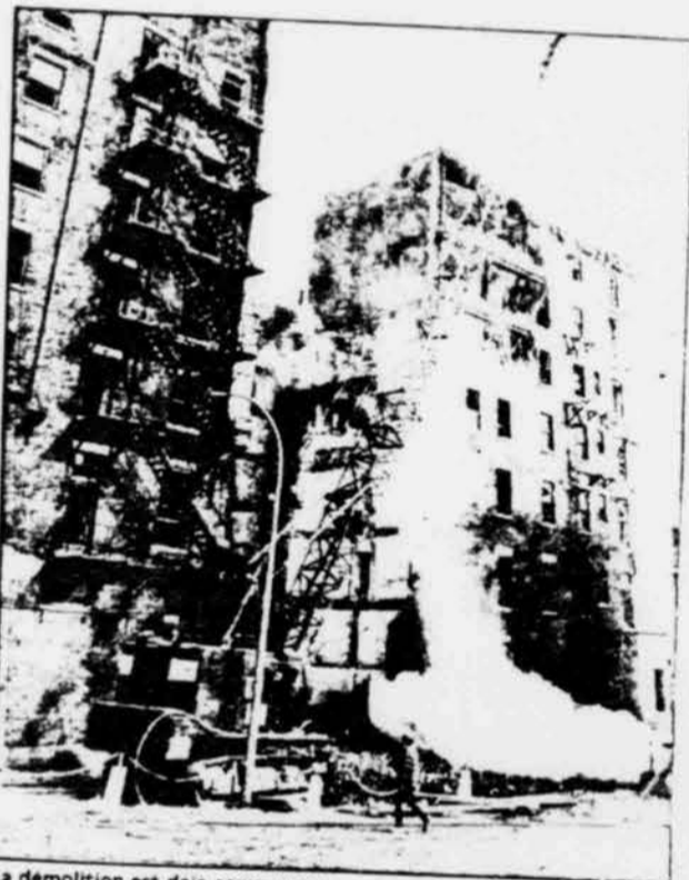
La démolition est déjà commencée.
