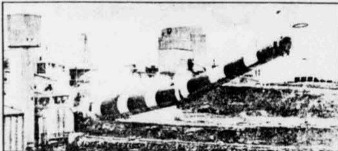
Les cheminées Miron sont finalement tombées.
