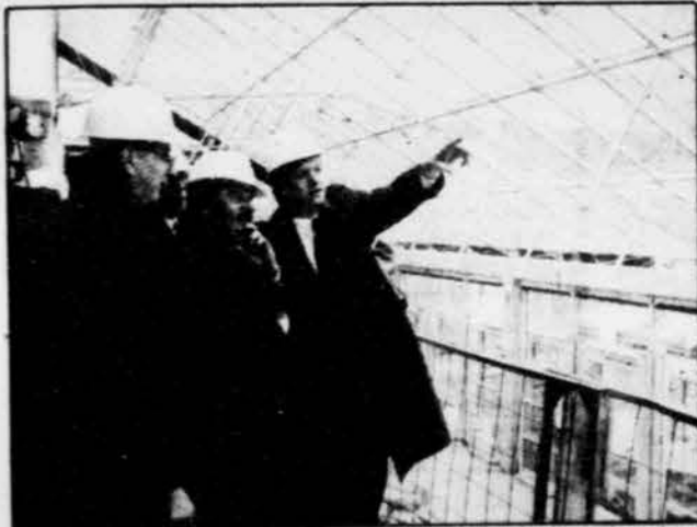
Le maire Doré a visité le chantier en compagnie de deux conseillers.
