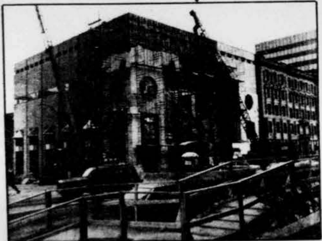
L'allure qu'avait le chantier, hier
